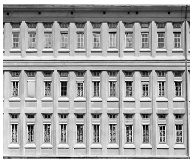
Bâtiment D : fenêtres de la façade sur la cour, avant restauration. Phot. Yves Sancey IVR43_20033900984X
