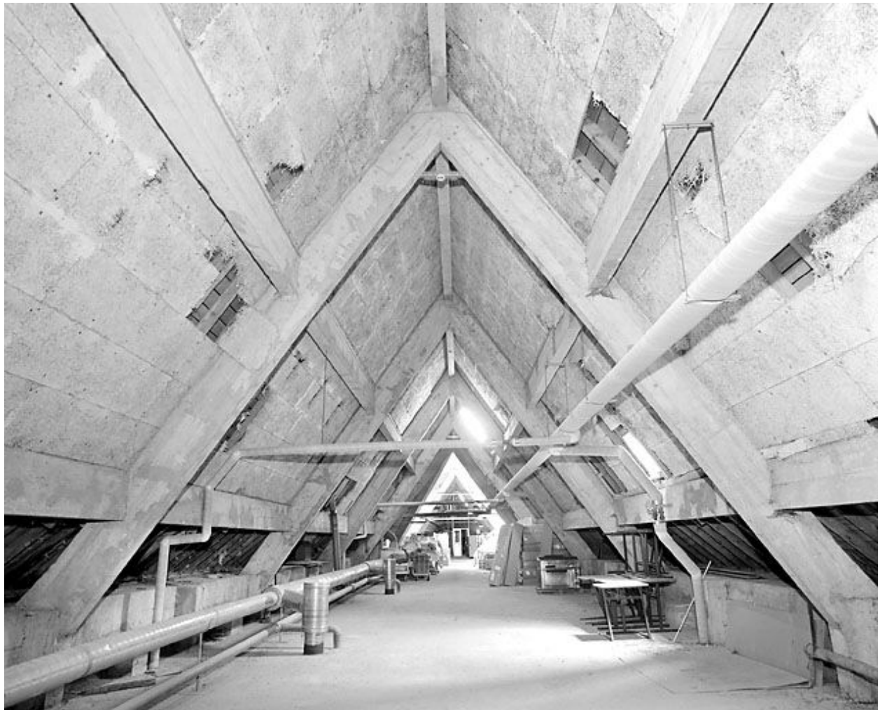
Bâtiment B : charpente en béton.
