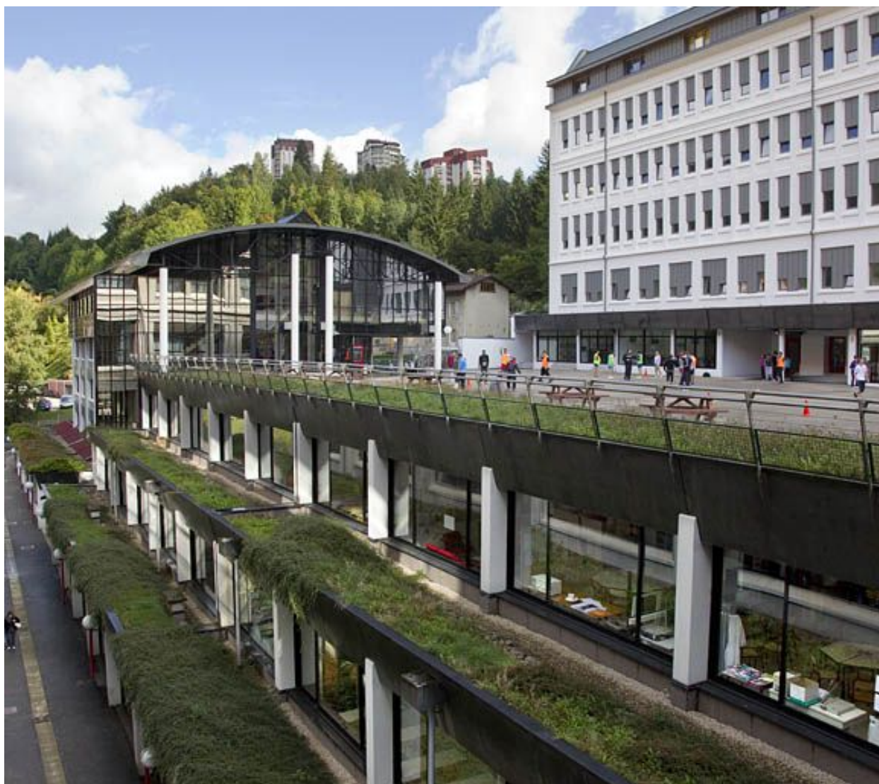
Bâtiments E et F : façade occidentale.
