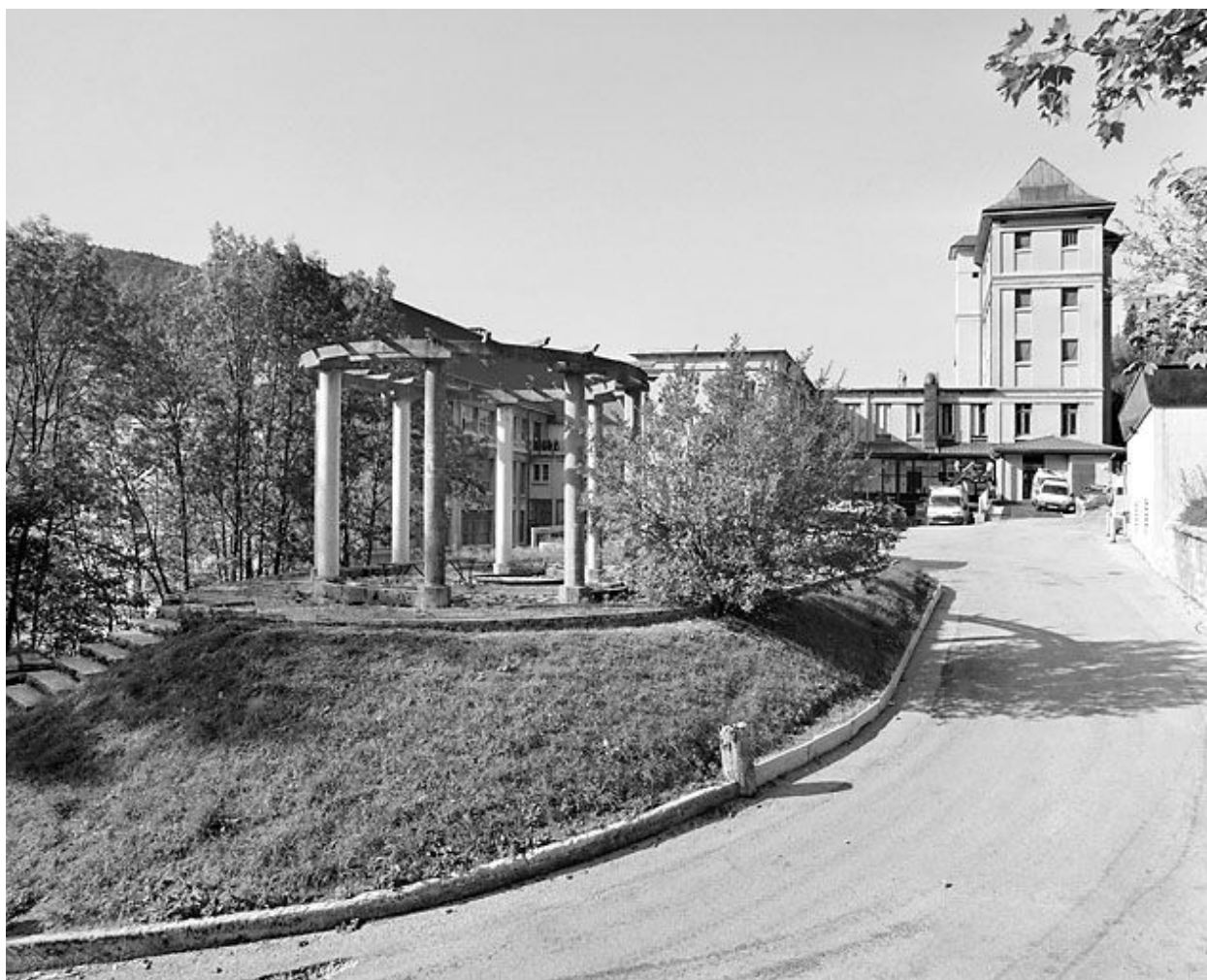
Bâtiment C (partiellement masqué par la rotonde de jardin) et extrémité du bâtiment D en arrière-plan.
