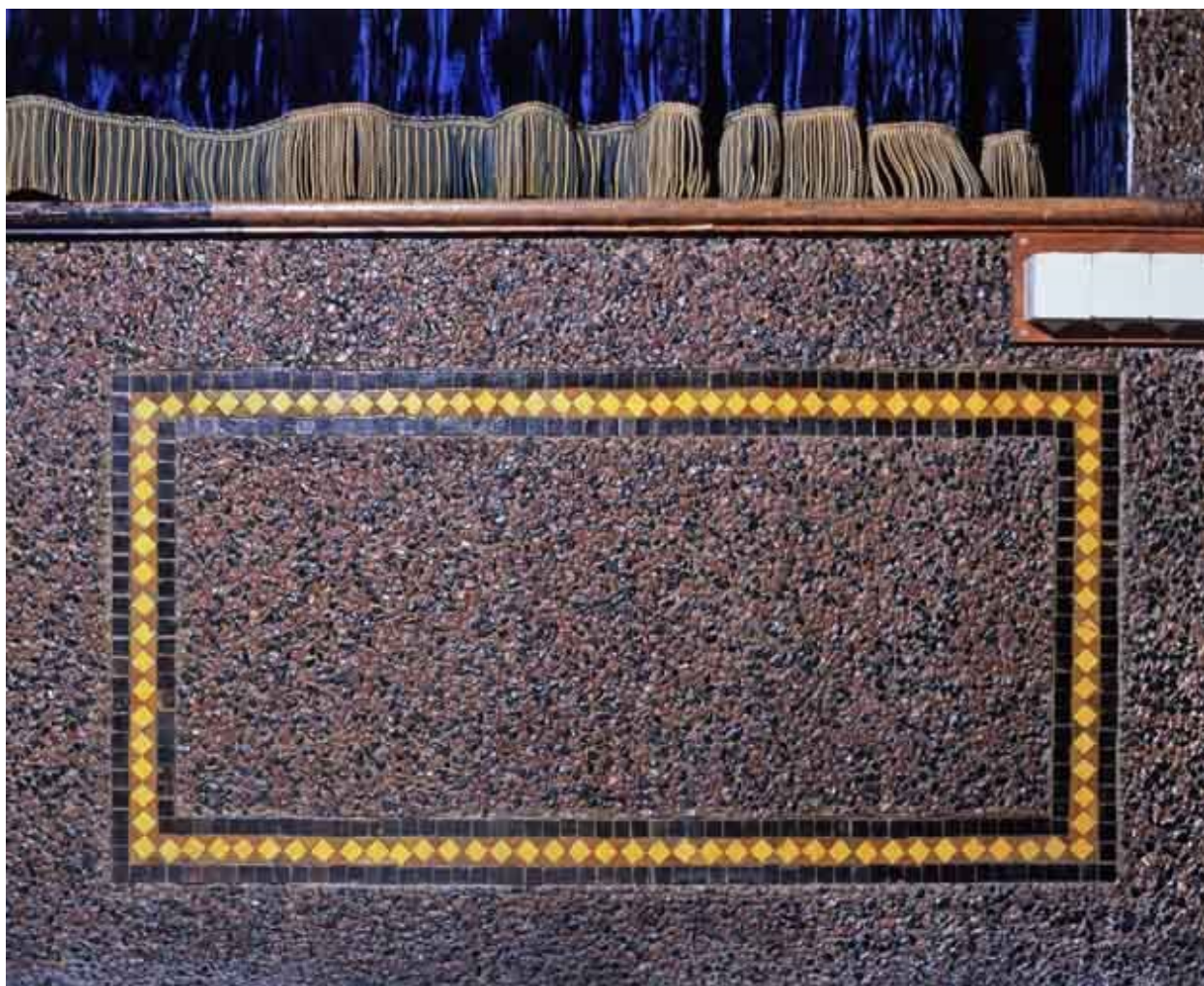
Bâtiment B, grand amphithéâtre : panneau alliant gravillons et mosaïques.
