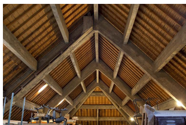
Bâtiment B : charpente en béton. Phot. Yves Sancey IVR43_20123900070NUC2A
