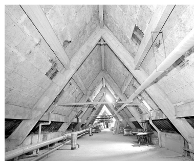
Bâtiment B : charpente en béton. Phot. Yves Sancey IVR43_20033900985X
