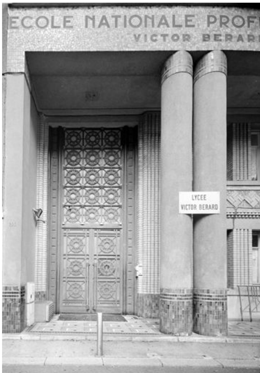
Bâtiment A : portail d'entrée.
