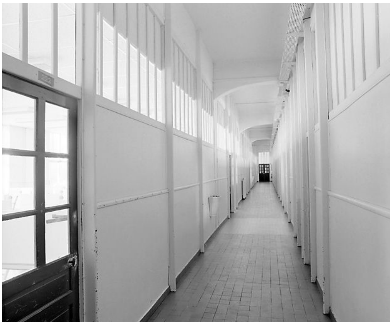
Bâtiment B : couloir au 2e étage. Les arcs en béton soutenant le plancher du 3e étage sont partiellement visibles.
