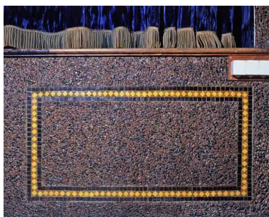
Bâtiment B, grand amphithéâtre : panneau alliant gravillons et mosaïques. Phot. Jérôme Mongreville IVR43_20023900405XA
