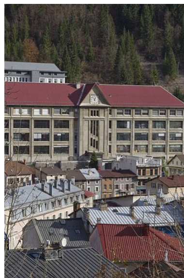
Bâtiment B : avant-corps. Phot. Yves Sancey IVR43_20123900089NUC2A
