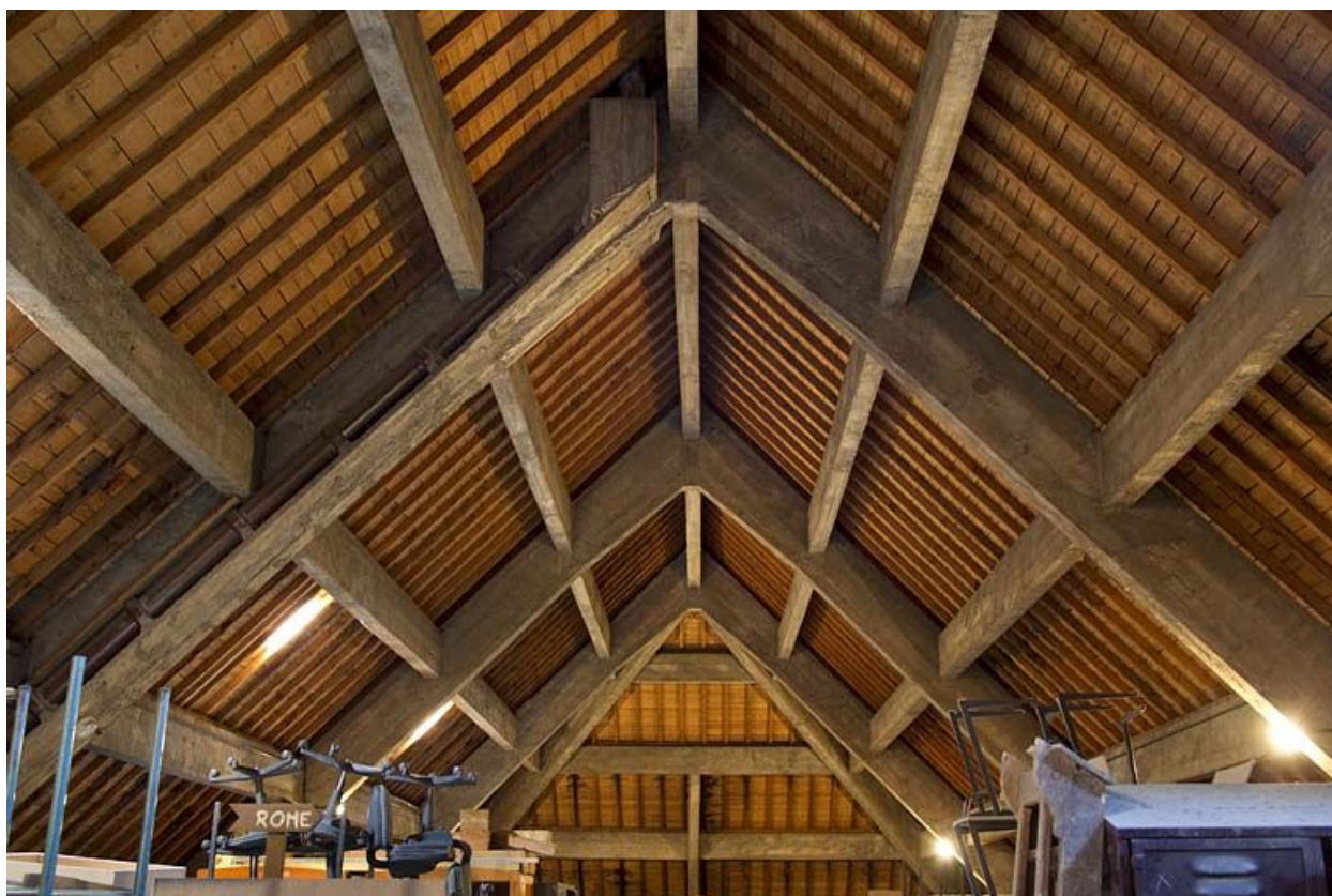
Bâtiment B : charpente en béton.
