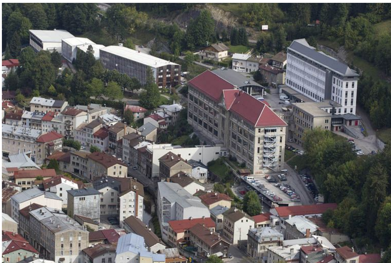
Vue d'ensemble plongeante, depuis le belvédère du Béchet au sud.
