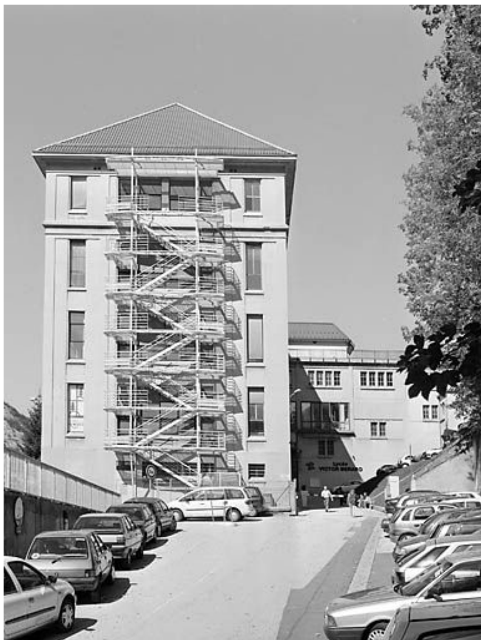
Bâtiment B : façade latérale droite.
