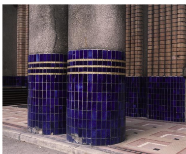
Bâtiment A : base des colonnes. Phot. Yves Sancey IVR43_20033900992XA
