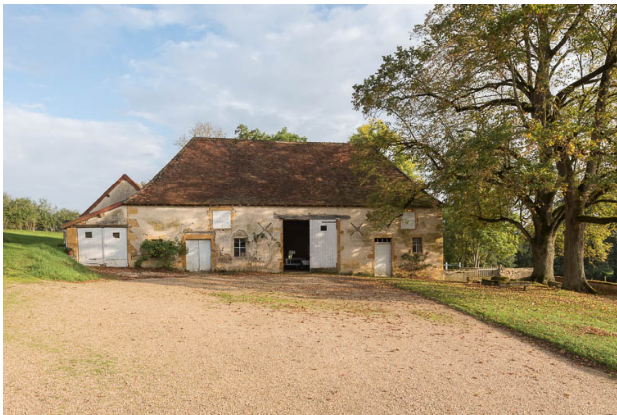
Façade antérieure de la grange
