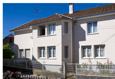
Façade latérale gauche. Phot. Yves Sancey IVR43_20132502150NUC2A
