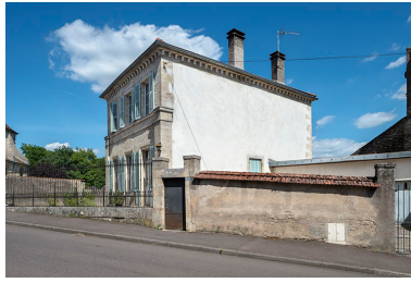
Le mur pignon sud-ouest. Phot. Jérôme Mongreville IVR43_20187000335NUC4A
