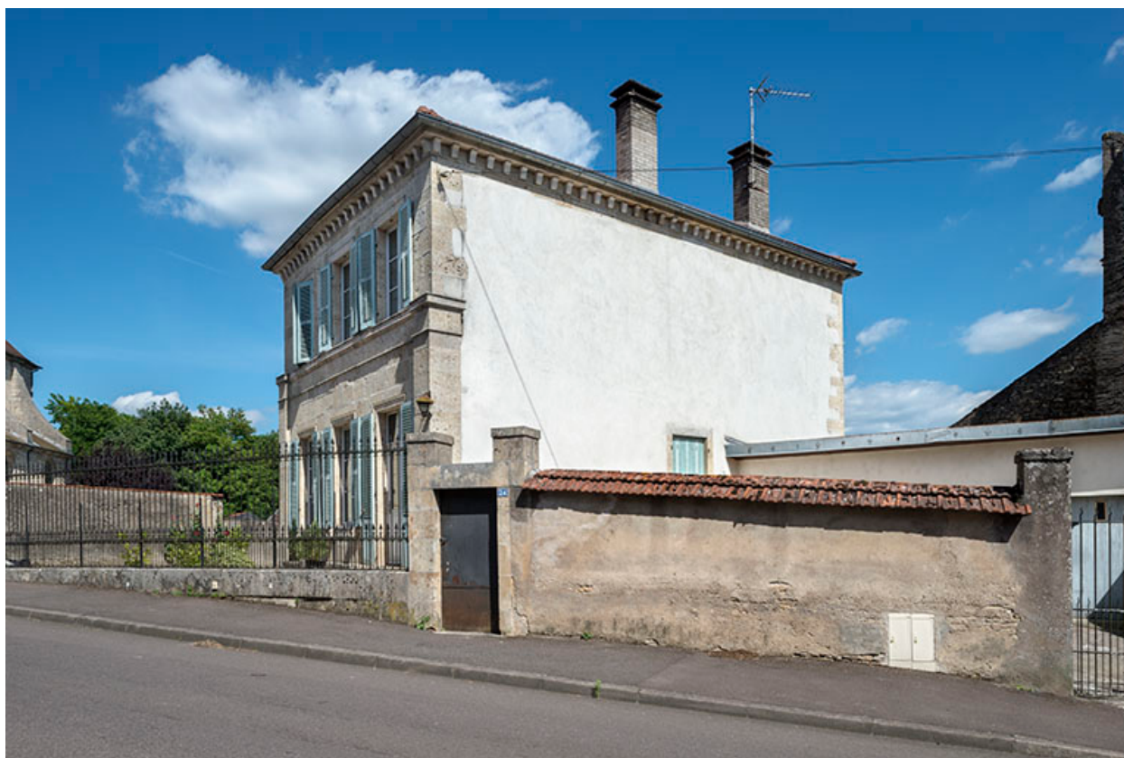
Le mur pignon sud-ouest.
