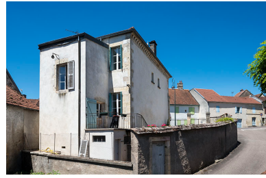
Façade postérieure. Phot. Jérôme Mongreville IVR43_20187000333NUC4A
