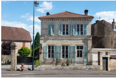
La façade antérieure. Phot. Jérôme Mongreville IVR43_20187000337NUC4A
