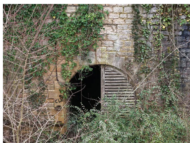
La porte et son vantail droit en bois. (vue aérienne). Phot. Nicolas Douriaux IVR26_20262100356NUC4A
