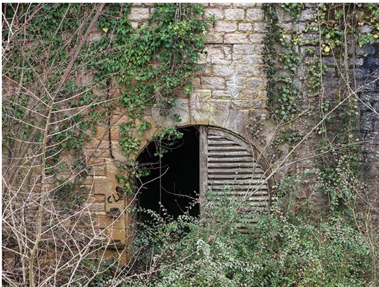
La porte et son vantail droit en bois. (vue aérienne).
