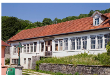
Façade antérieure de l'atelier. Phot. Yves Sancey IVR43_20132501225NUC2A
