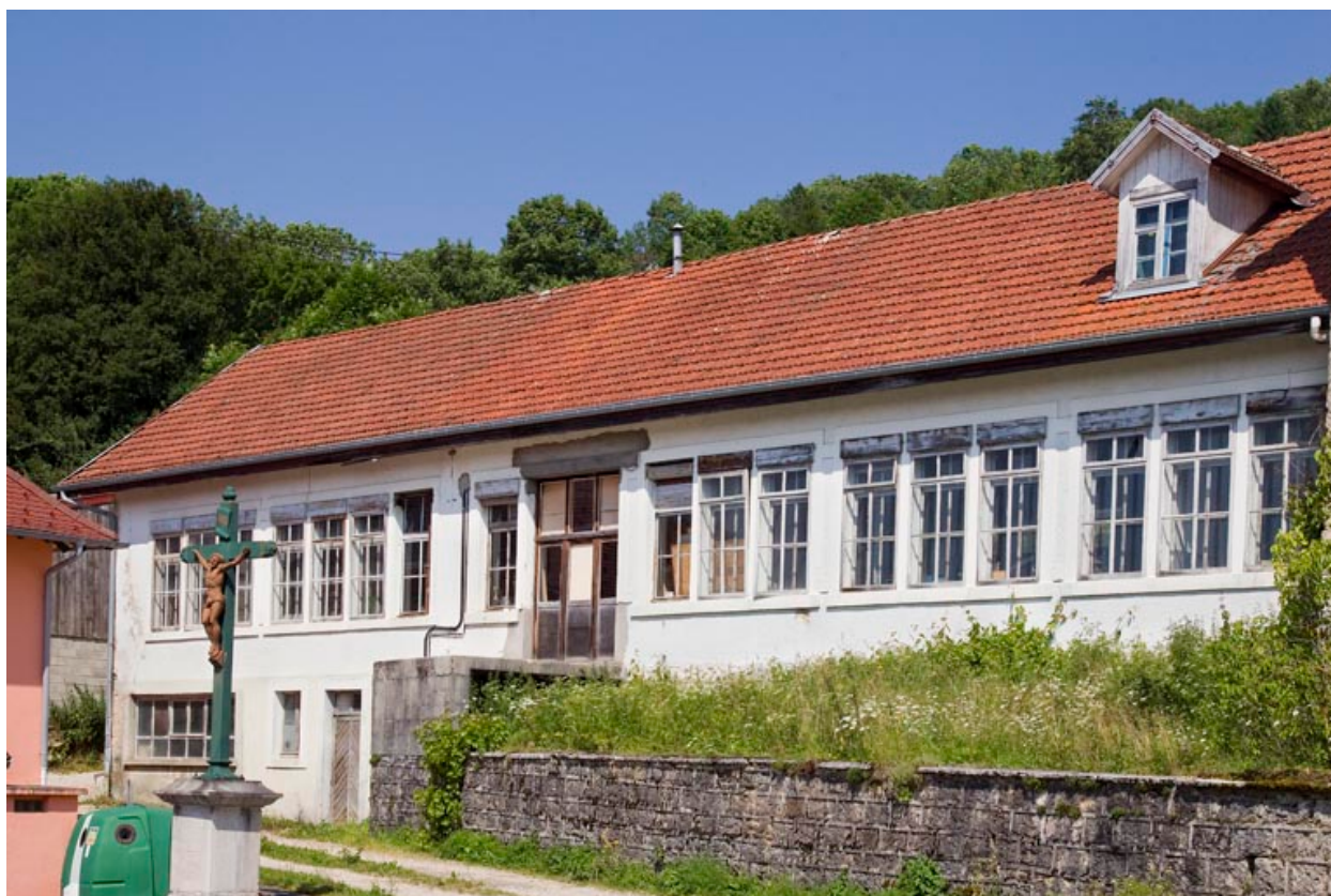
Façade antérieure de l'atelier.
