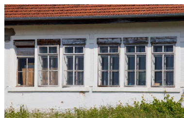
Détail des fenêtres de l'atelier. Phot. Yves Sancey IVR43_20132501226NUC2A
