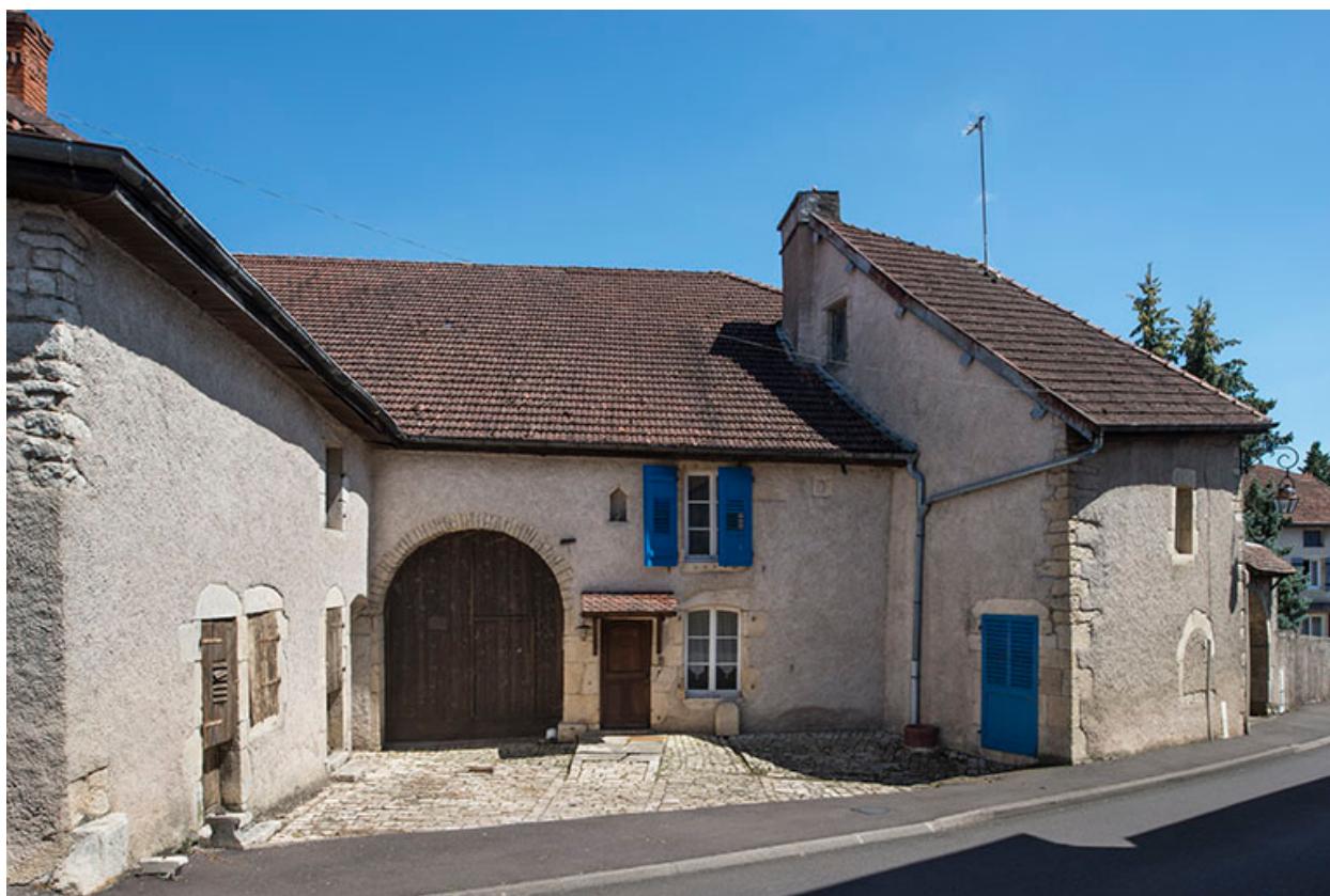
La façade antérieure et la cour.
