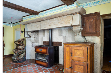
La cheminée de la pièce principale. Phot. Jérôme Mongreville IVR43_20187000753NUC4A
