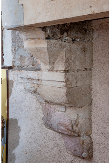
Console supportant la cheminée. Phot. Jérôme Mongreville IVR43_20187000755NUC4A
