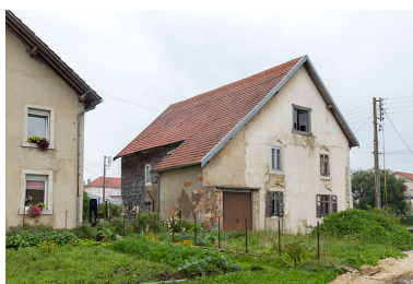
Façade latérale gauche. Phot. Yves Sancey IVR43_20132503022NUC2A
