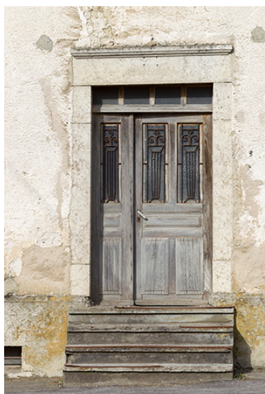
Façade antérieure : porte. Phot. Sonia Dourlot IVR43_20152500857NUC2A
