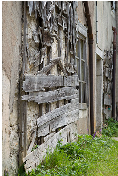
Façade postérieure : support de l'essente de tavaillons, vu en enfilade.
