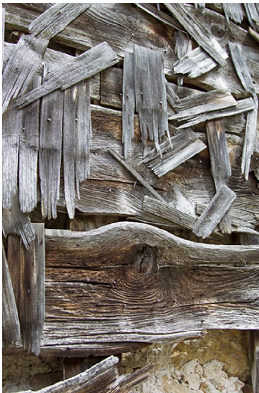
Façade postérieure : support de l'essentage de tavaillons, avec quelques tavaillons.
