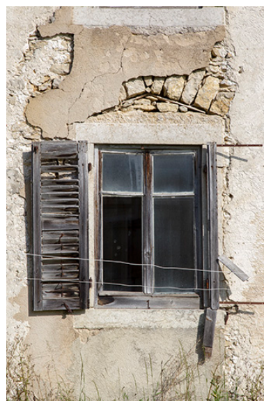
Façade latérale gauche : fenêtre surmontée d'un arc de décharge. Phot. Sonia Dourlot IVR43_20152500860NUC2A
