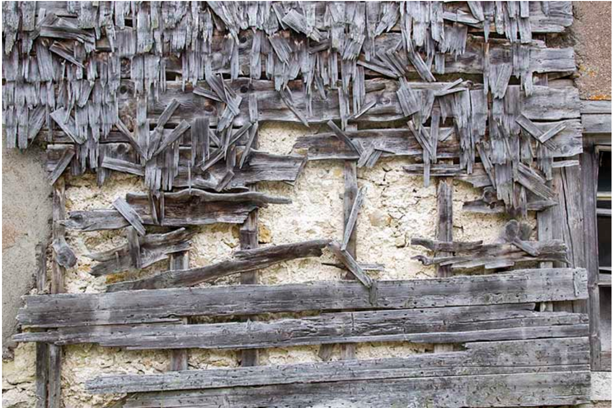
Façade postérieure : vestiges de l'essentage de tavaillons.
