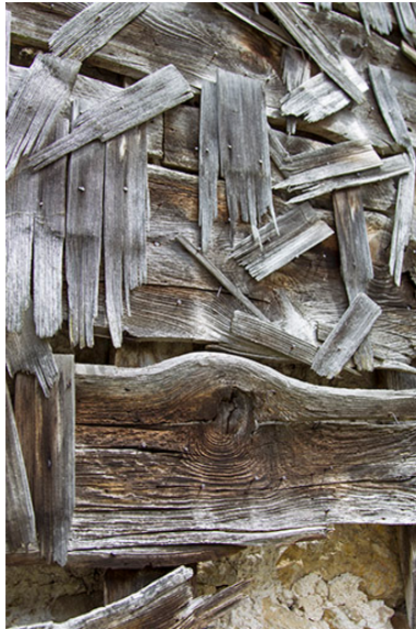
Façade postérieure : support de l'essente de tavaillons, avec quelques tavaillons.
