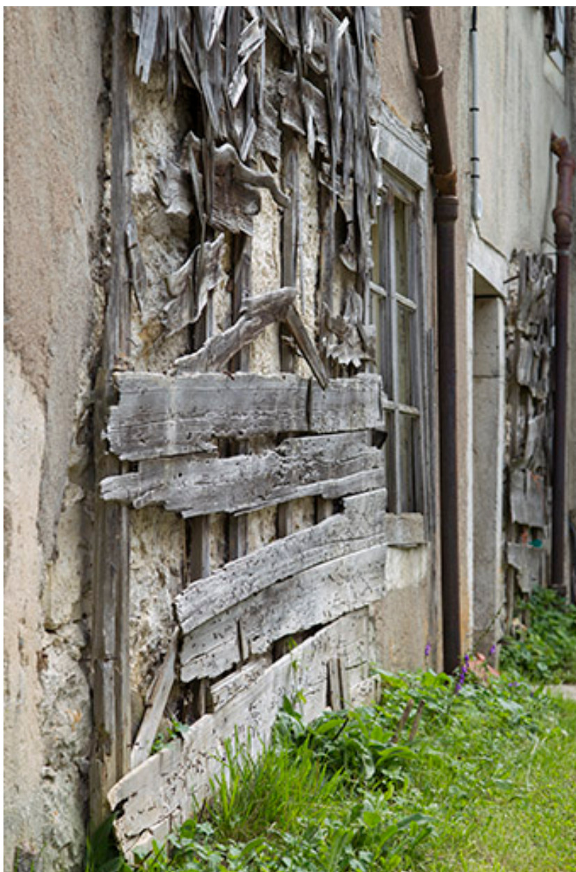
Façade postérieure : support de l'essentage de tavaillons, vu en enfilade.
