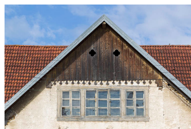
Façade antérieure : pignon. Phot. Sonia Dourlot IVR43_20152500855NUC2A
