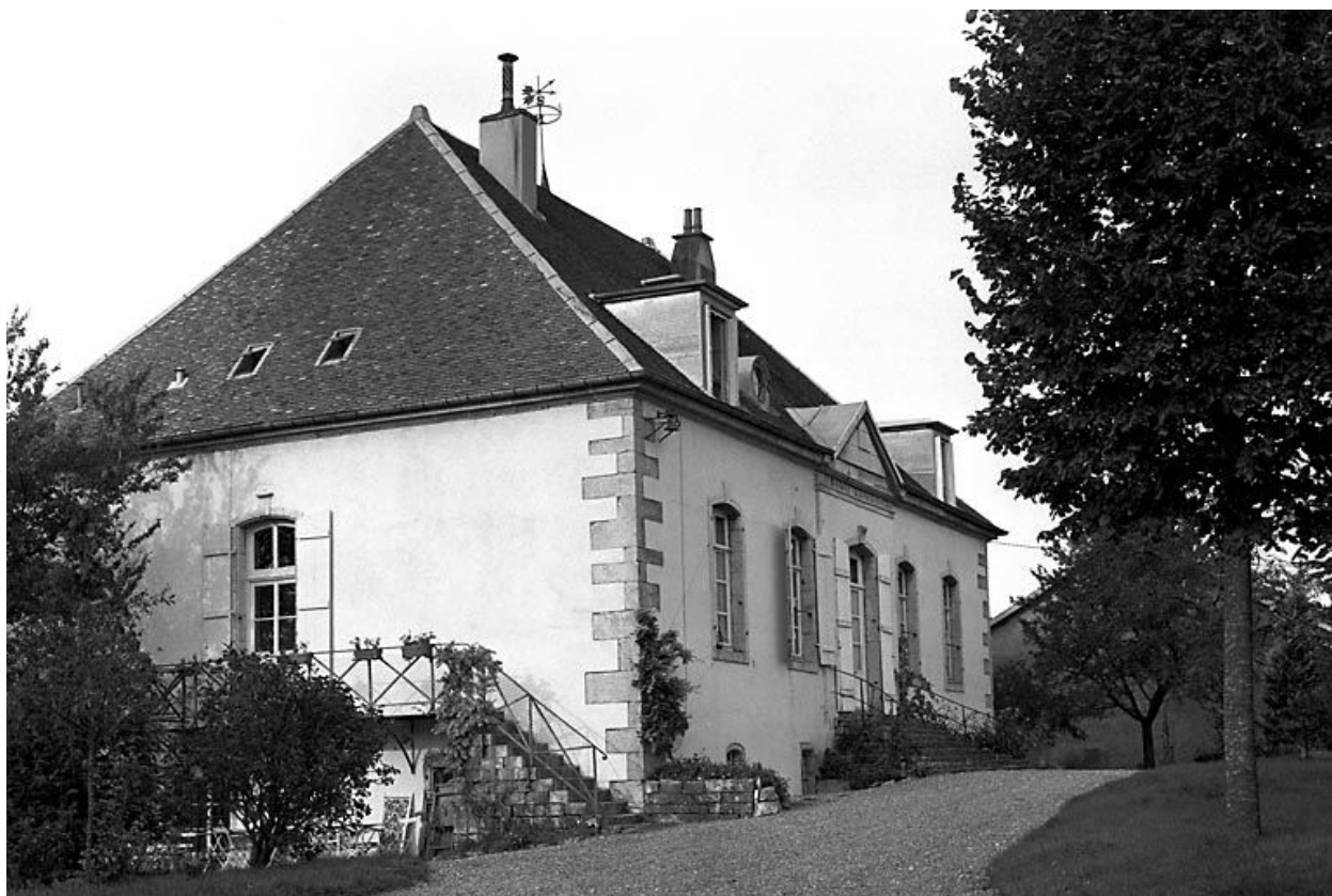
Maison située rue des Granges de Céry.
