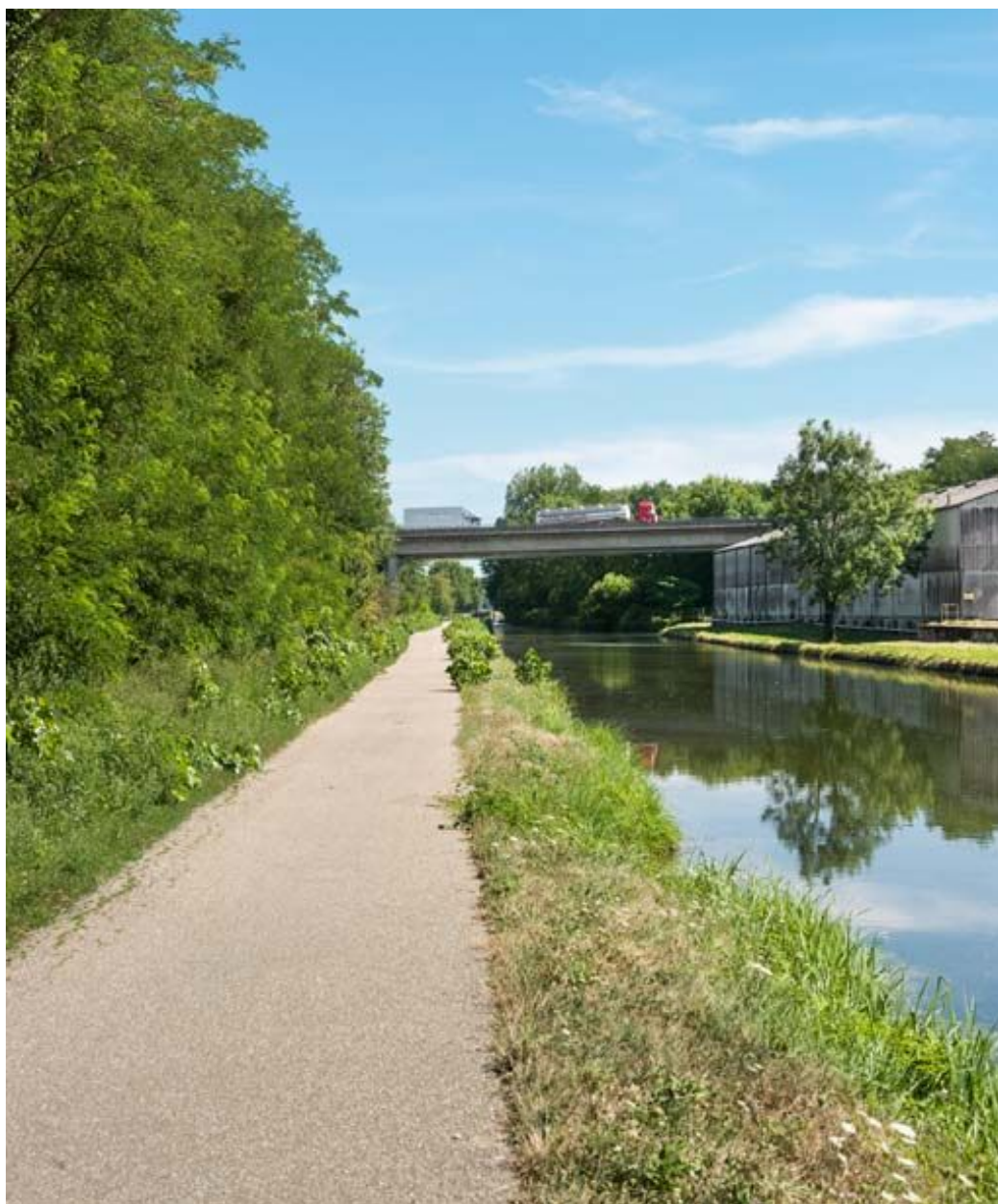
Vue d'ensemble du pont.
