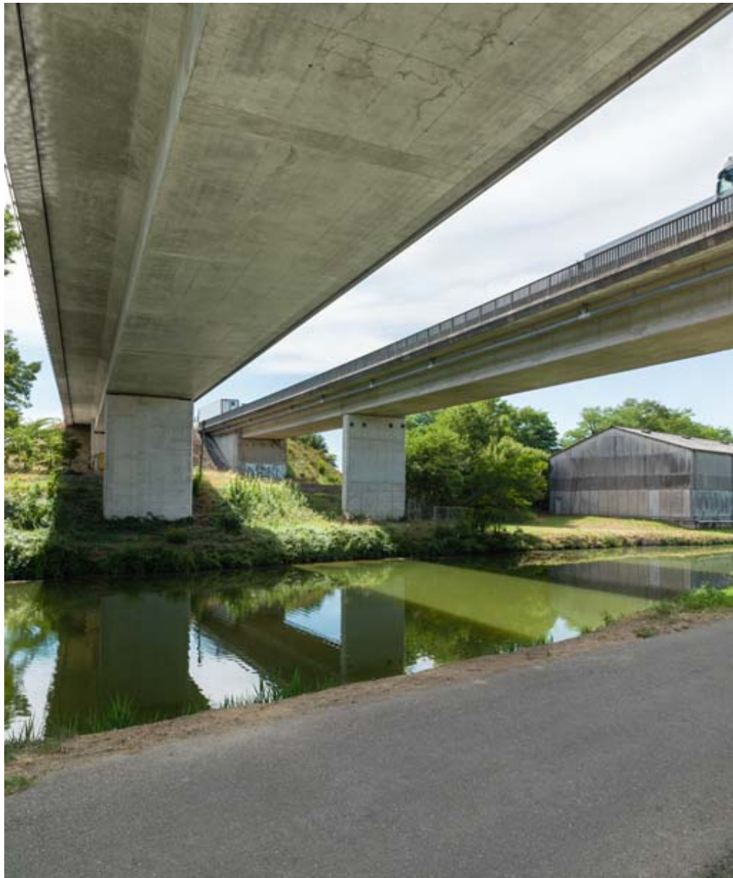
VUe rapprochée du pont.
