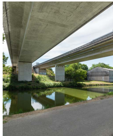
VUe rapprochée du pont. Phot. Pierre-Marie Barbe-Richaud IVR26_20177100248NUC2A
