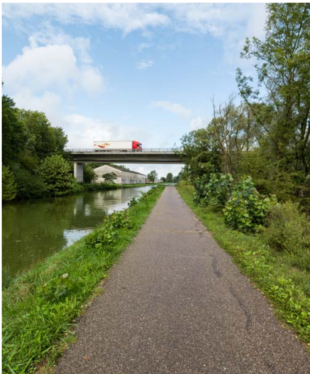
Vue d'ensemble du pont.
