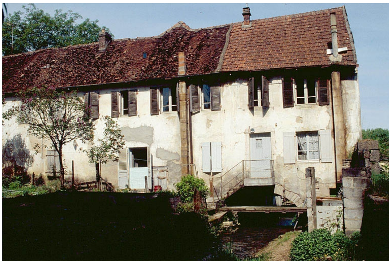
Bâtiment d'eau et logement depuis le sud-est.
