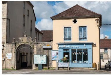
Élévation sur la rue Armand-Paulmard, vue de face. Phot. Jérôme Mongreville IVR43_20187000397NUC4A
