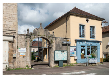
Élévation sur la rue Armand-Paulmard, vue de trois quarts. Phot. Jérôme Mongreville IVR43_20187000399NUC4A
