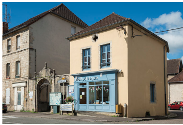
Élévation sur la rue Armand-Paulmard, vue de trois quarts. Phot. Jérôme Mongreville IVR43_20187000396NUC4A
