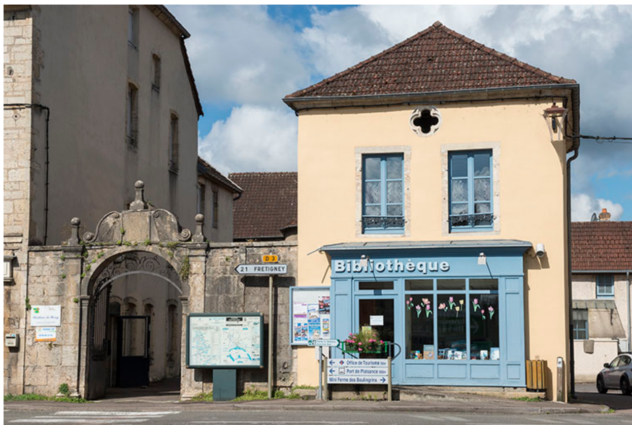
Élévation sur la rue Armand-Paulmard, vue de face.
