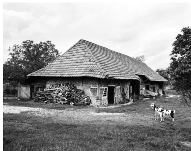
Bâtiment d'exploitation : façades antérieure et latérale gauche.
