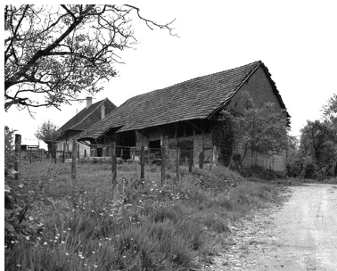
Bâtiment d'exploitation : façades antérieure et latérale droite.
