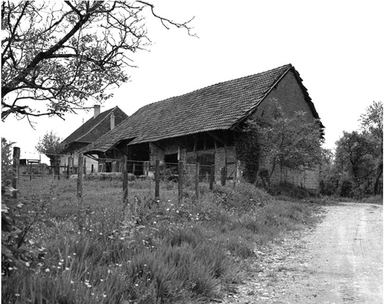
Bâtiment d'exploitation : façades antérieure et latérale droite.
