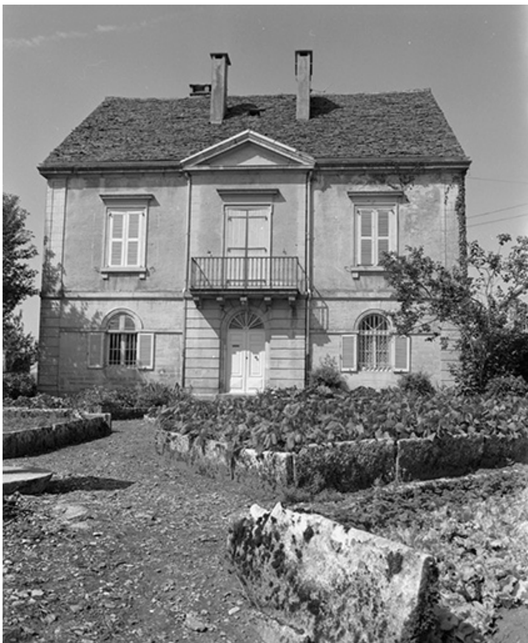
Façade antérieure et jardin.
