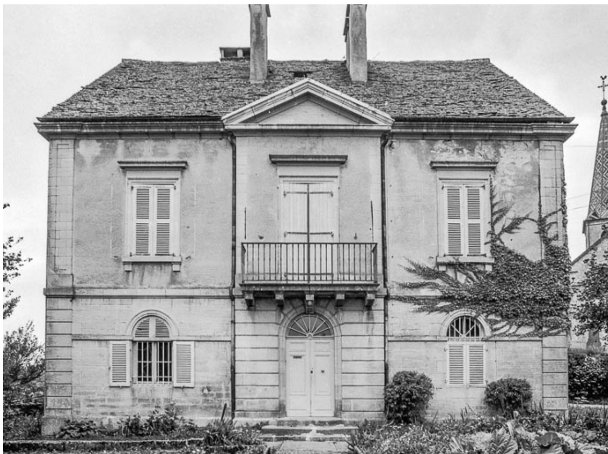
Façade antérieure vue rapprochée de face.
