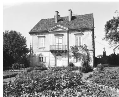
Façade antérieure vue de face. Phot. Yves Sancey IVR43_19793900104X
