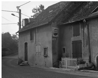
Façade antérieure vue de trois quarts. Phot. Dominique Dominguez IVR43_19803900220X
