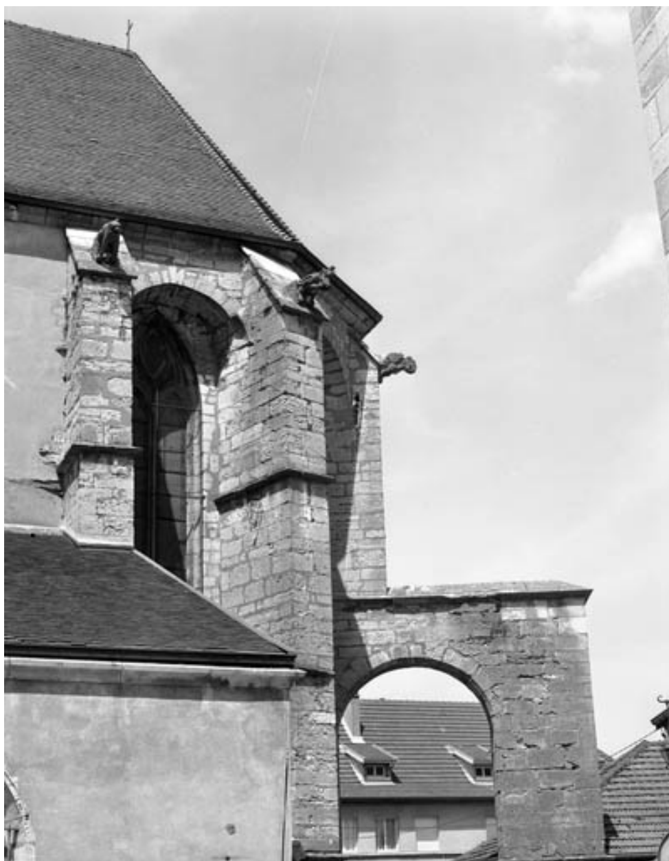
Chevet : détail des contreforts partie droite.
