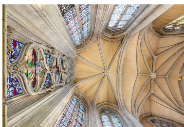
Voute et abside du chœur en 2022. Phot. Jérôme Mongreville IVR43_20227000335NUC4A
