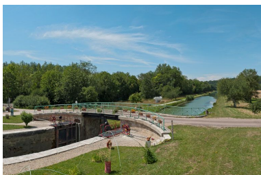
Vue du pont depuis l'amont.
