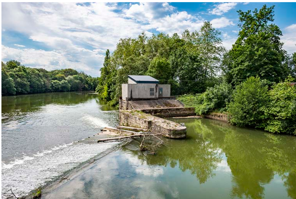
Digue maçonnée où se situait l'ancien pertuis.
