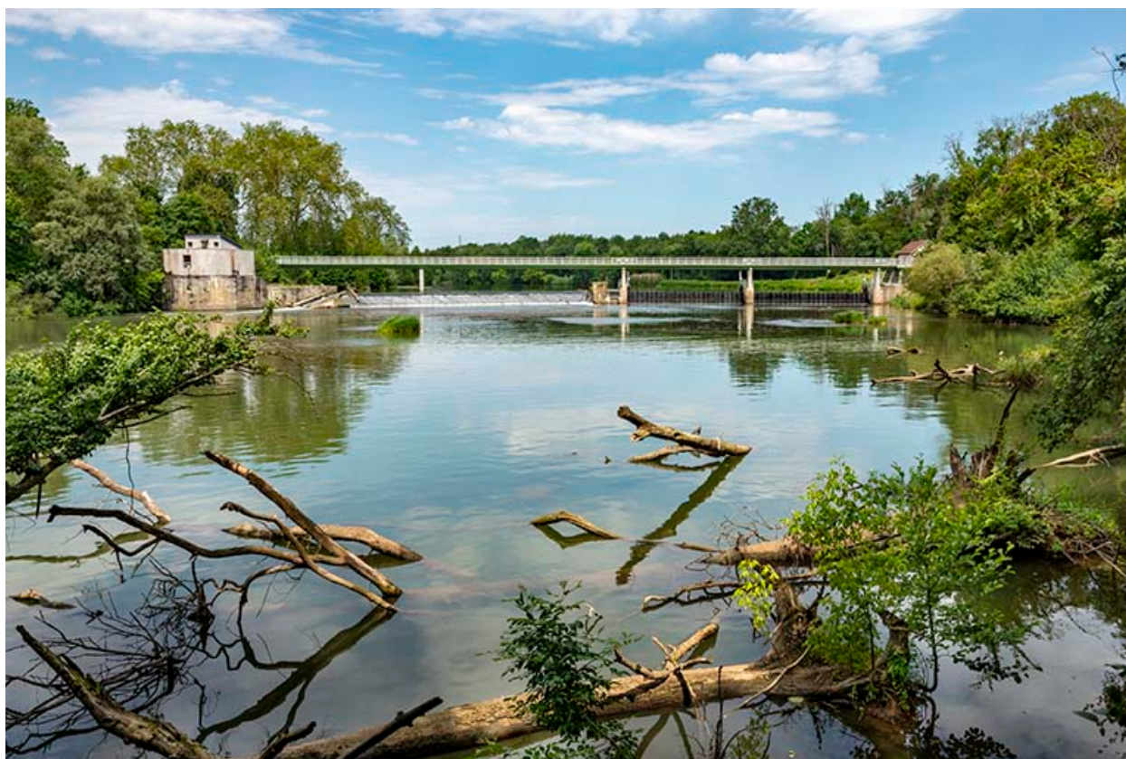
Vue générale depuis l'aval.
