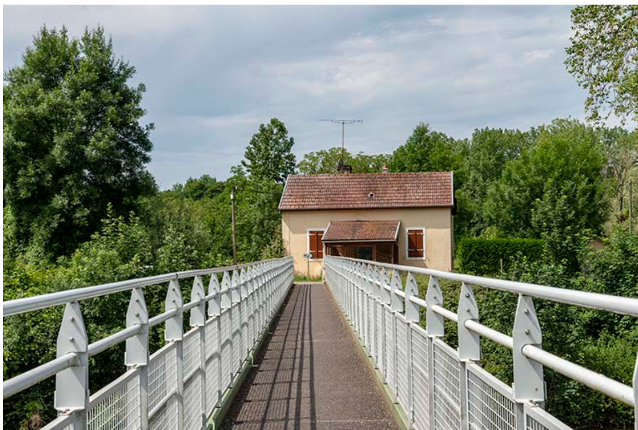
Vue de détail de la passerelle.
