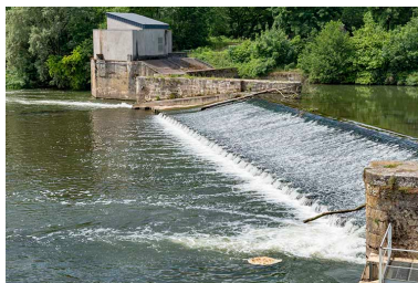
Le déversoir, détail. Phot. Jérôme Mongreville IVR43_20197000400NUC4A
