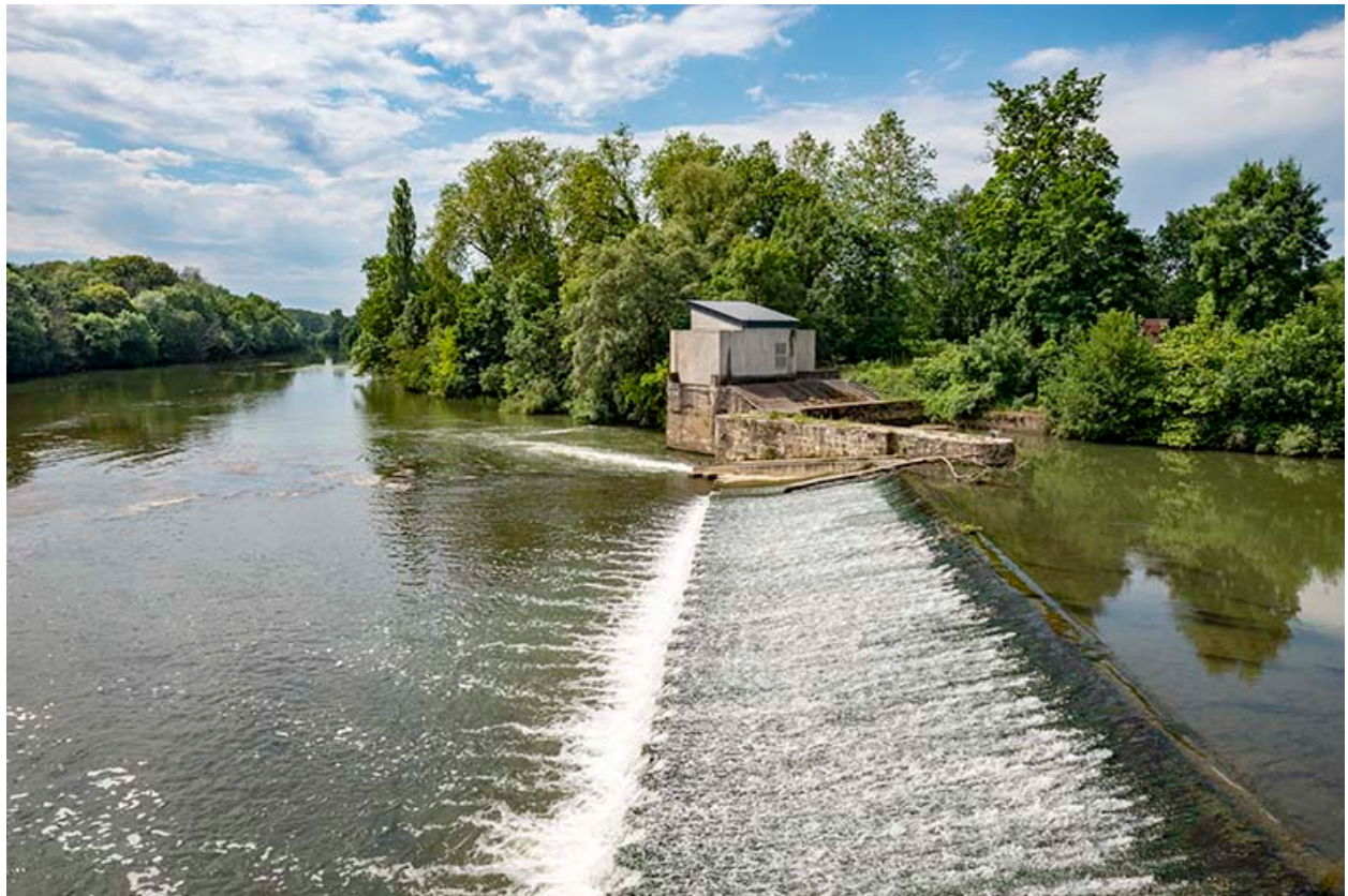
Vue générale sur le déversoir.
