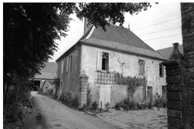
Façade sur cour de l'habitation gauche. Phot. Bernard Lardière IVR43_19797000127Z
