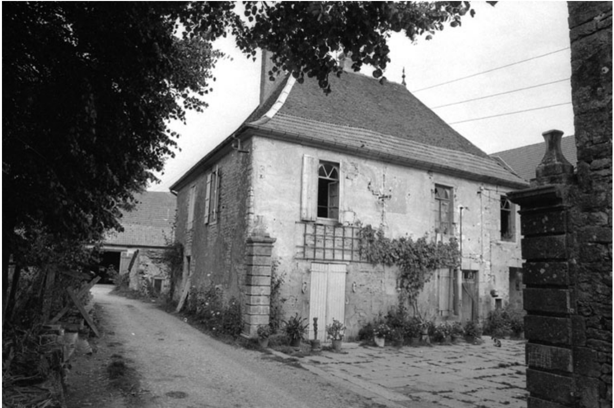
Façade sur cour de l'habitation gauche.
