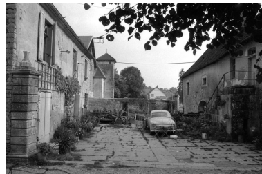
Façades sur cour des deux habitations. Phot. Bernard Lardière IVR43_19797000128Z
