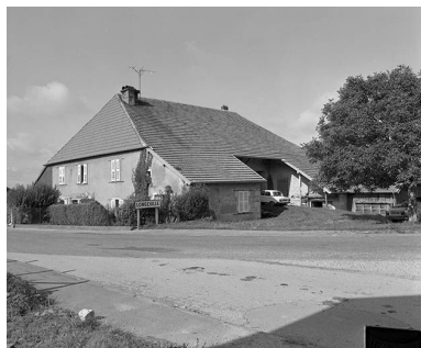
Ferme située 56 Grande Rue. Phot. Yves Sancey IVR43_19802501037X
