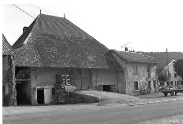
Ferme située 5 Grande Rue. Phot. Yves Sancey IVR43_19802501025X
