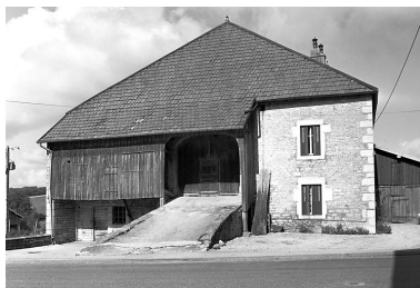
Ferme située Grande Rue, en face de la mairie. Phot. Yves Sancey IVR43_19802501043X
