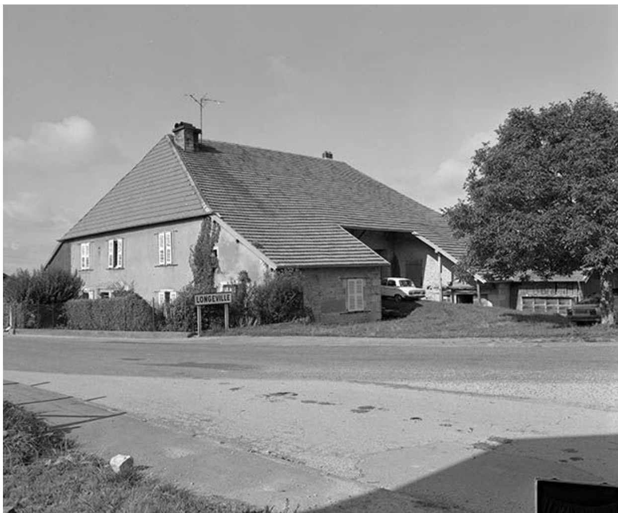
Ferme située 56 Grande Rue.
