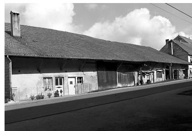
Ferme située Grande Rue. Phot. Yves Sancey IVR43_19802501034X
