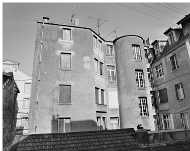
Façades sur cour. Phot. Jérôme Mongreville IVR43_19872500565X
