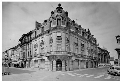
Vue d'ensemble. Phot. Jérôme Mongreville IVR43_19872500271V
