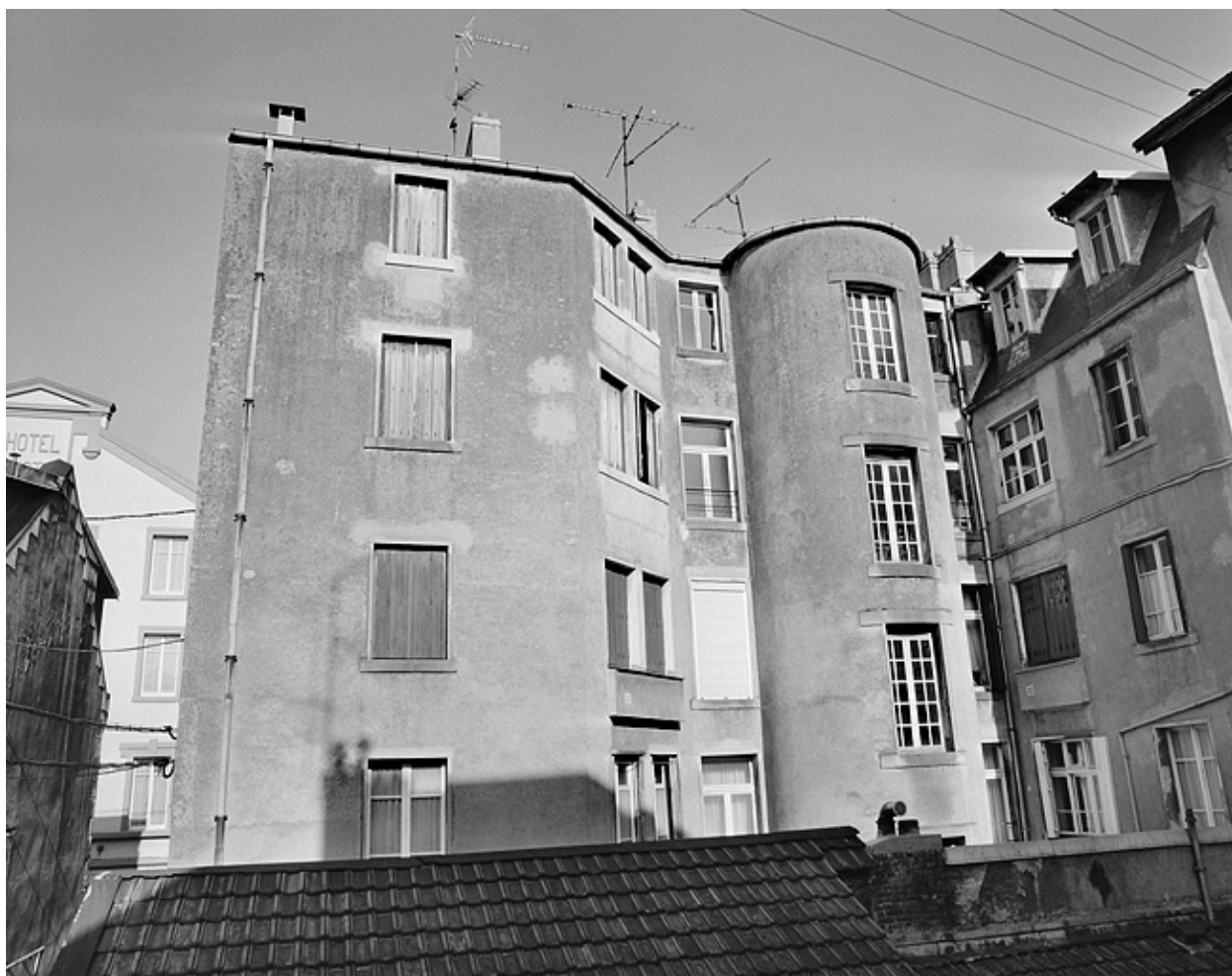
Façades sur cour.
