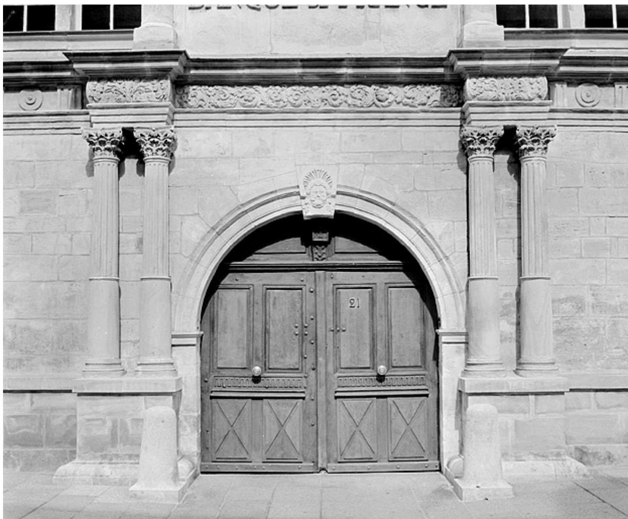
Façade sur la place, portail.
