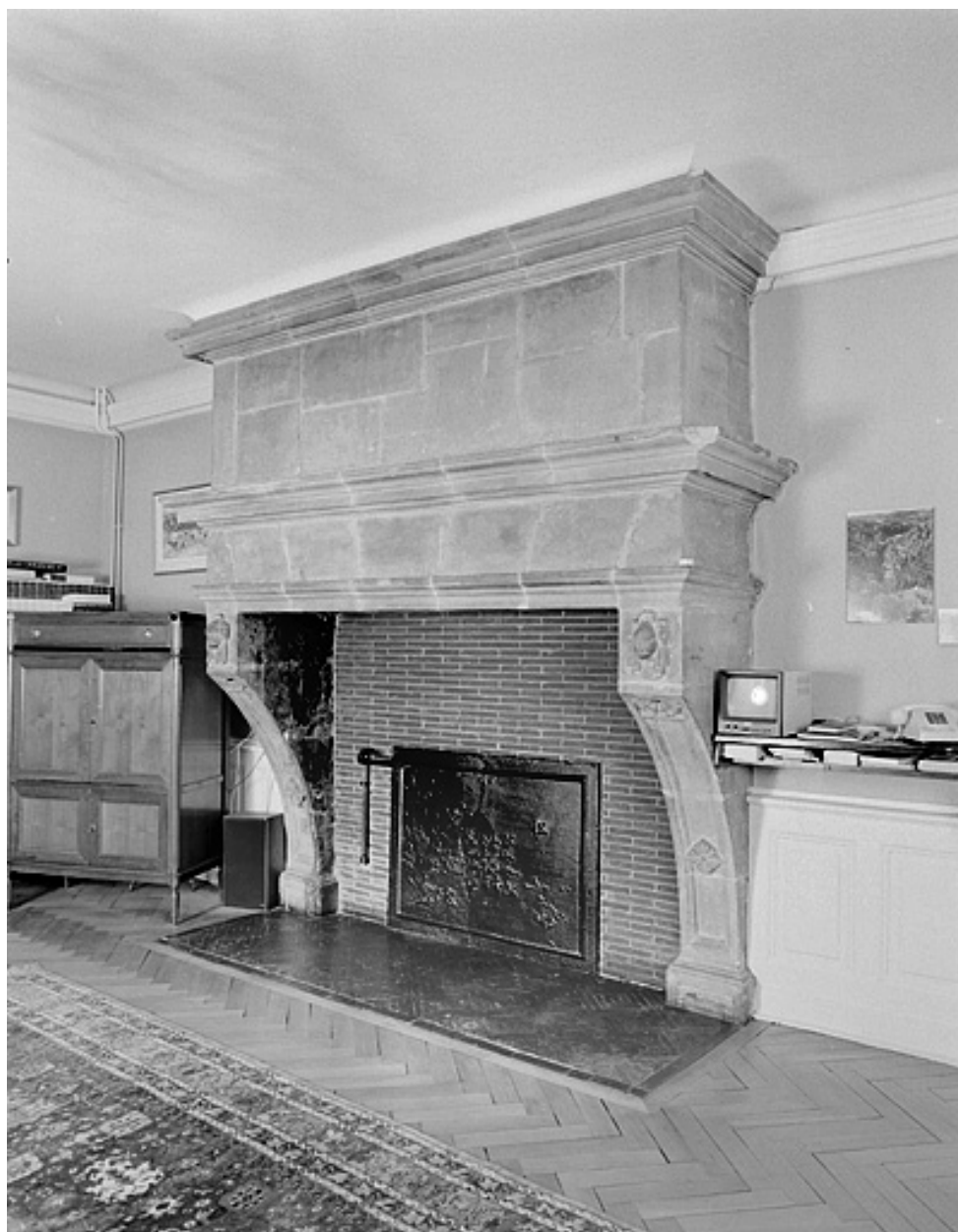
Première cheminée au deuxième étage.
