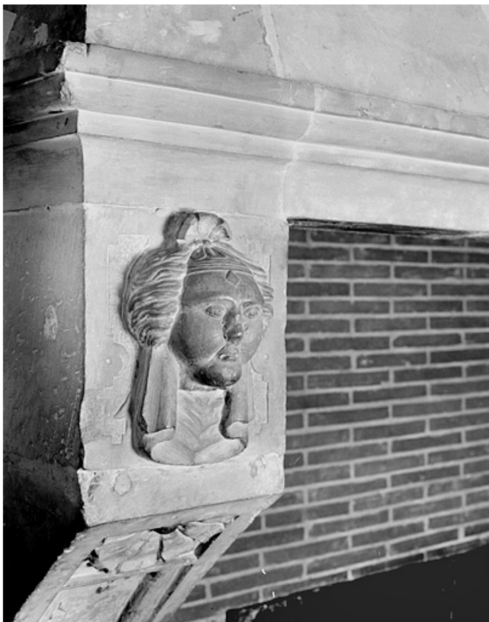
Première cheminée au deuxième étage, détail.
