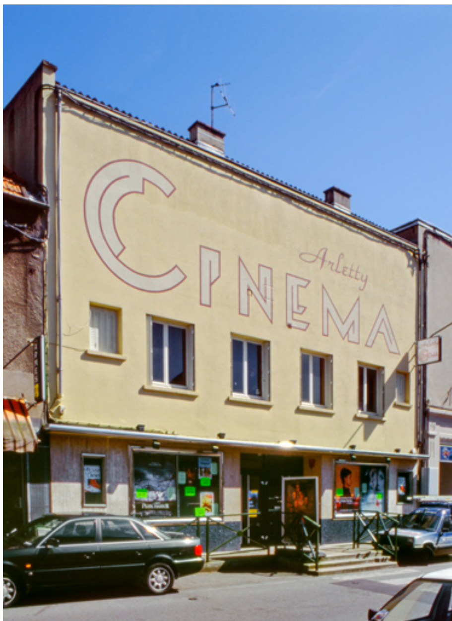
Façade antérieure de trois quarts gauche, en 2001.
