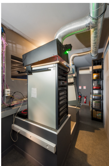
Cabine de la salle 4. Projecteurs numérique Barco (à gauche) et argentique Hortson. Phot. Pierre-Marie Barbe-Richaud IVR26_20257100176NUC4A
