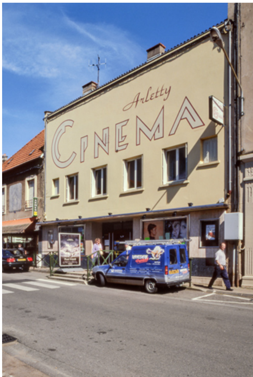
Façade antérieure de trois quarts droite, en 2001.
