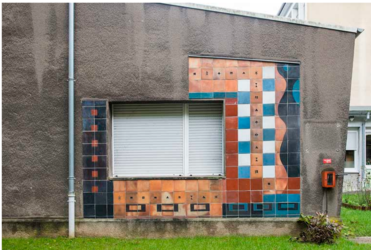
Oeuvre de Bizette. Façade sur rue.
