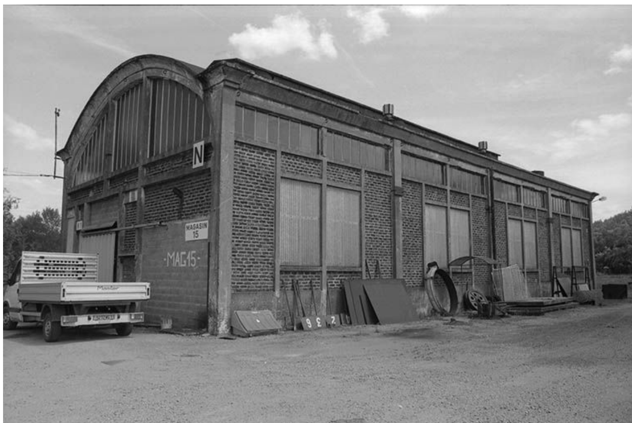
Ancien hangar des locomotives.
