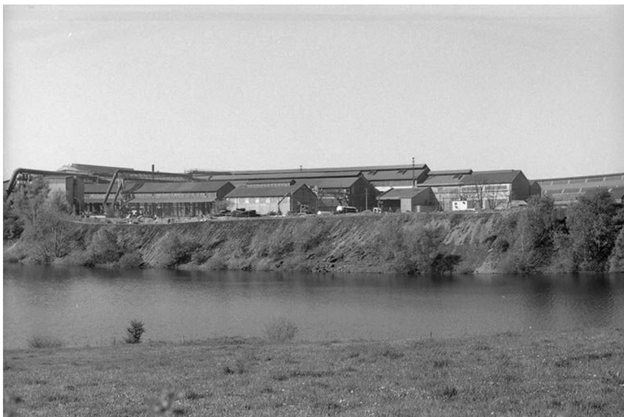
Vue de l'aciérie depuis le nord-est.
