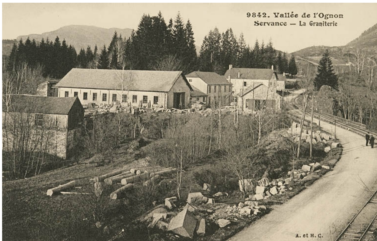
Vallée de l'Ognon. Servance - La graniterie.
