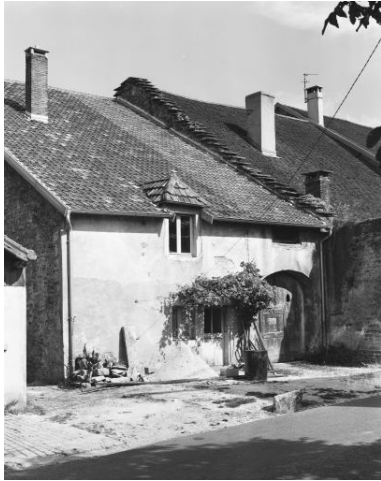
Façade antérieure. Phot. Dominique Dominguez IVR43_19803900186X
