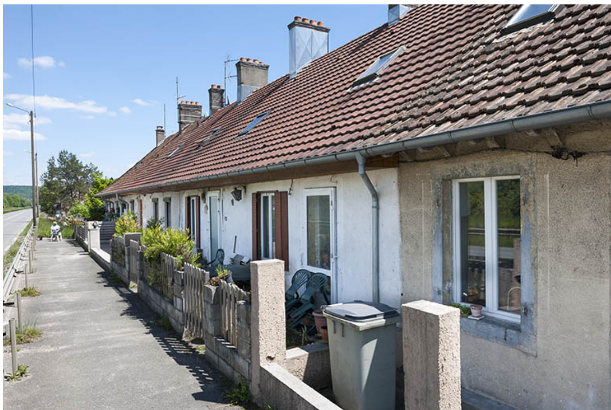
Façade nord d'une habitation de type caserne.
