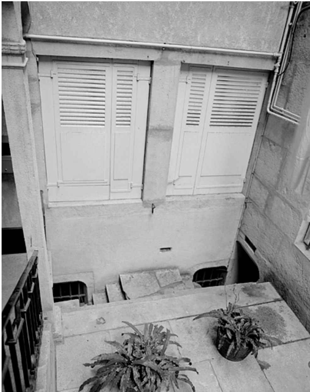
Descentes de caves dans la cour.
