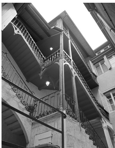
Escalier dans la cour. Phot. Yves Sancey IVR43_19833900668X
