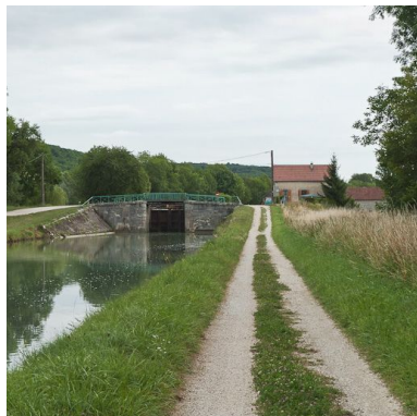
Vue du pont depuis l'aval. Phot. Pierre-Marie Barbe-Richaud IVR26_20118900357NUC2AQ
