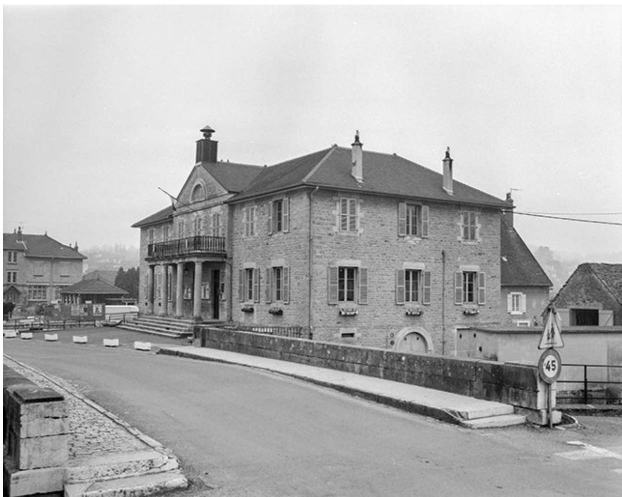
Façade antérieure et face droite.
