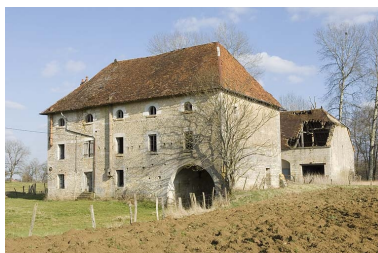
Vue depuis l'ouest. Phot. Jérôme Mongreville IVR43_20097000273NUC2A
