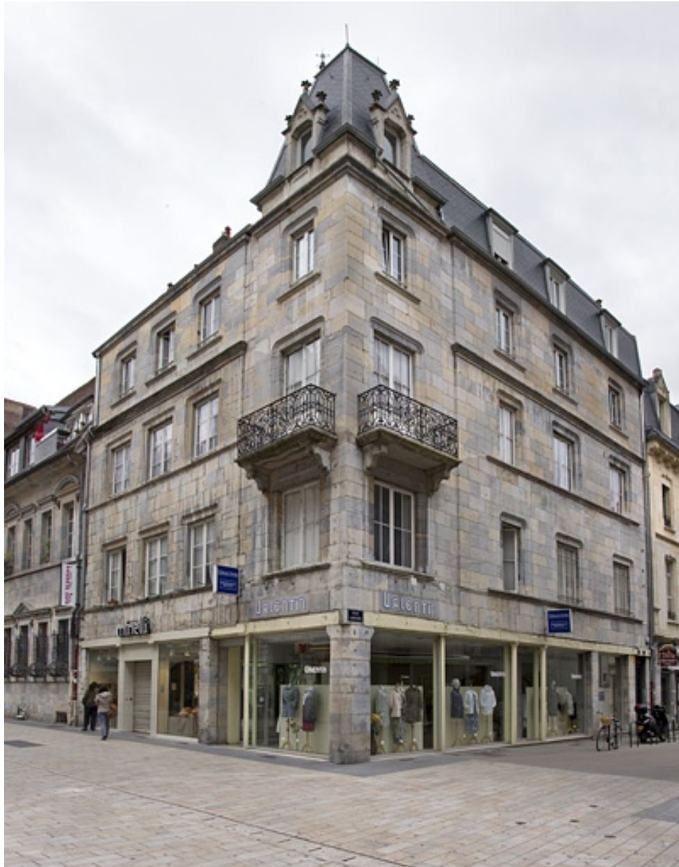
Vue d'ensemble du logis principal.
