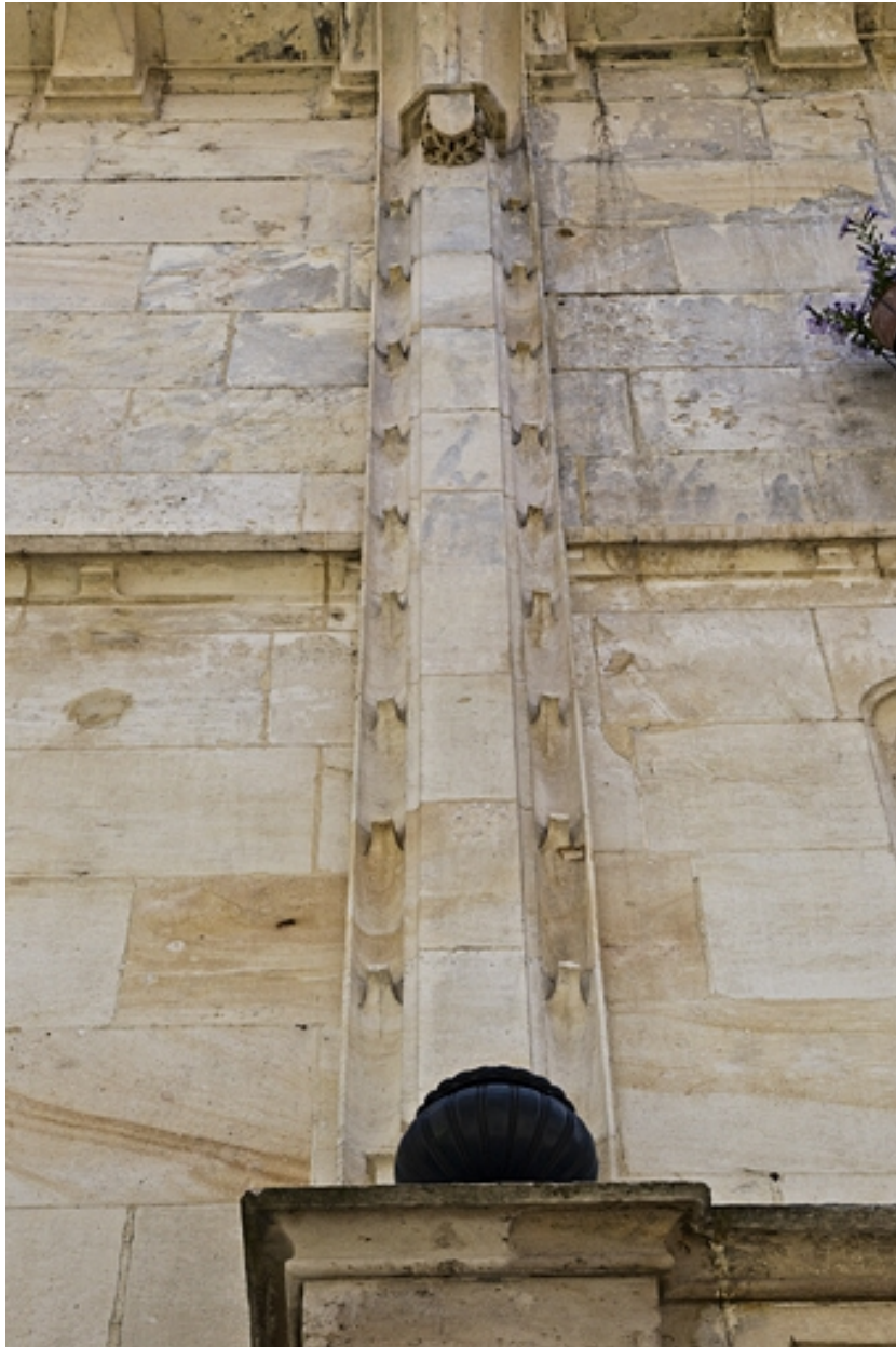
Logis secondaire, façade antérieure : détail d'un pilastre.
