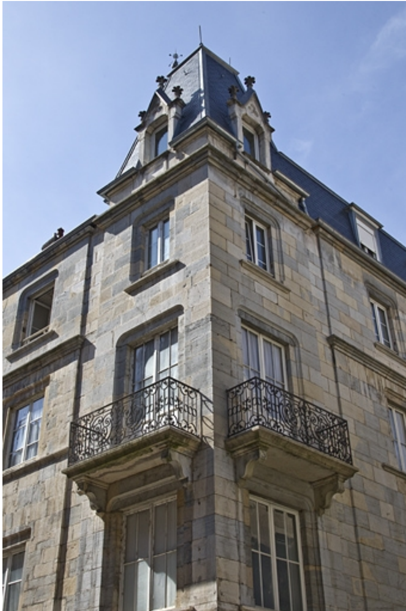
Vue rapprochée de l'angle du logis principal.
