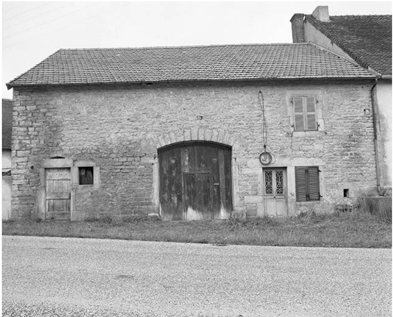
Façade antérieure, de face.
