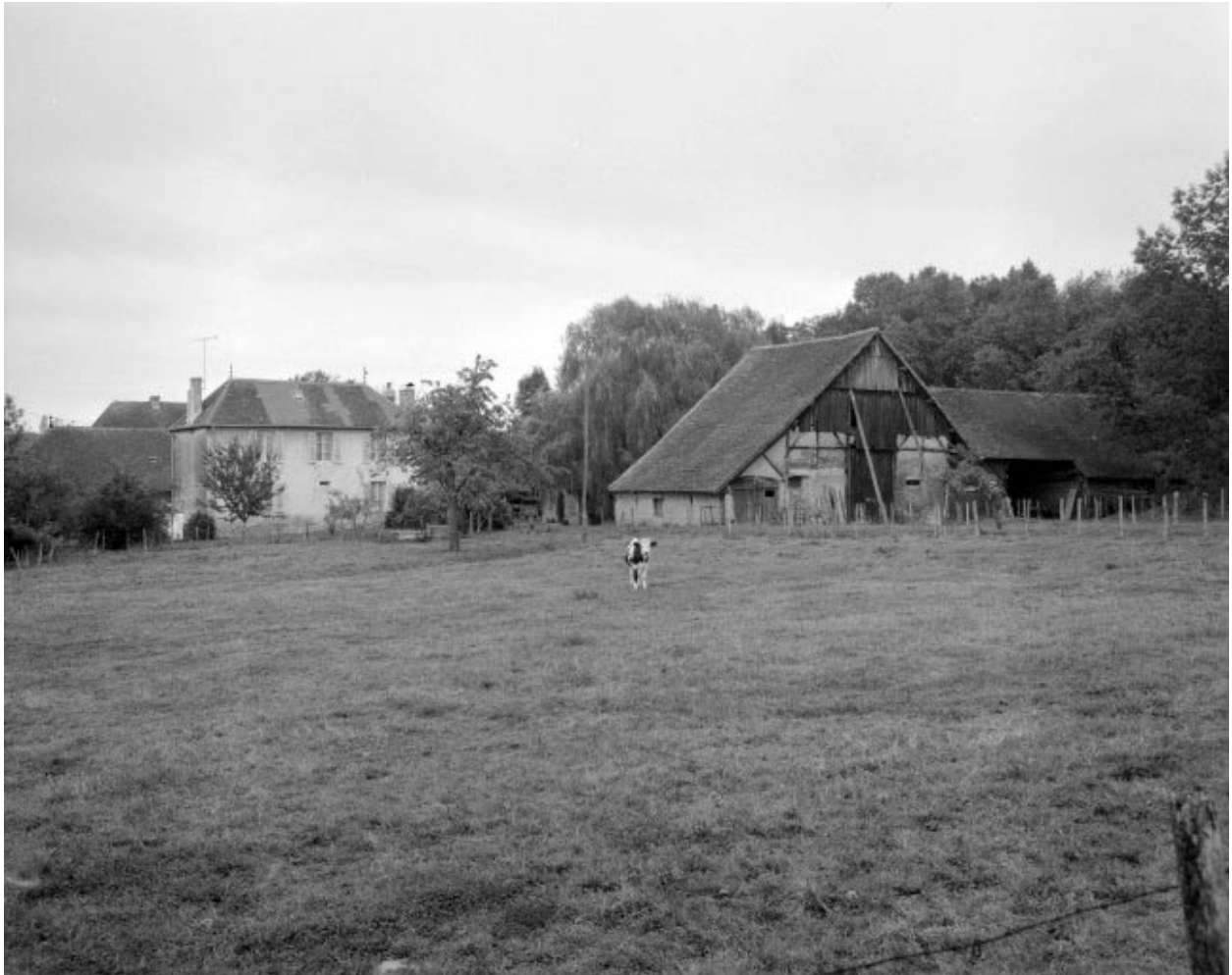
Tuilerie-briqueterie située dans l'impasse de la Tuilerie.
