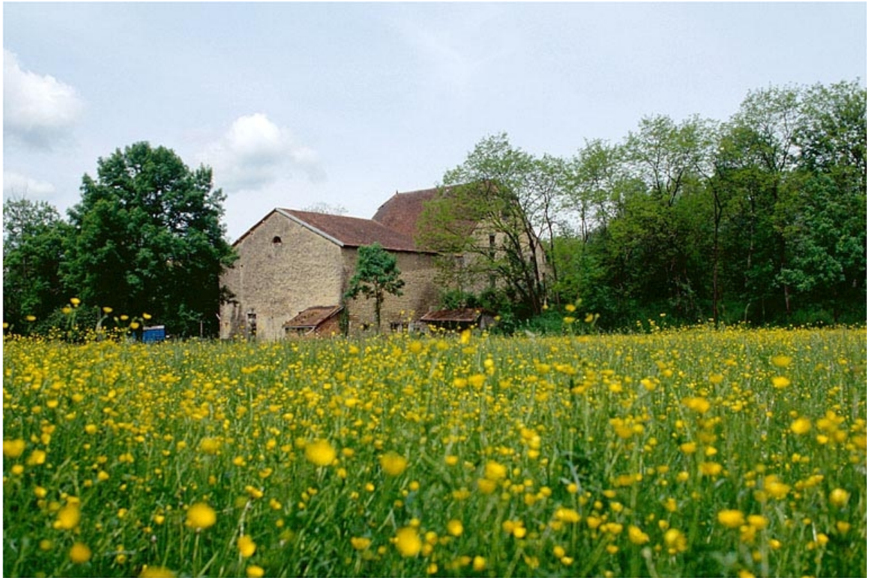
Moulin situé rue du Château.
