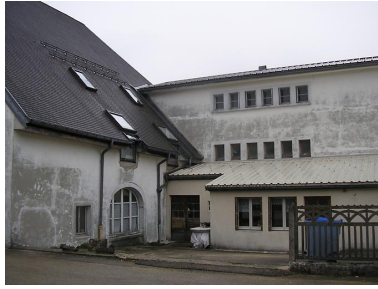
Vue de trois quarts sur cour intérieure. Phot. Anne-Laure Madinier IVR43_20083900597NUC1A
