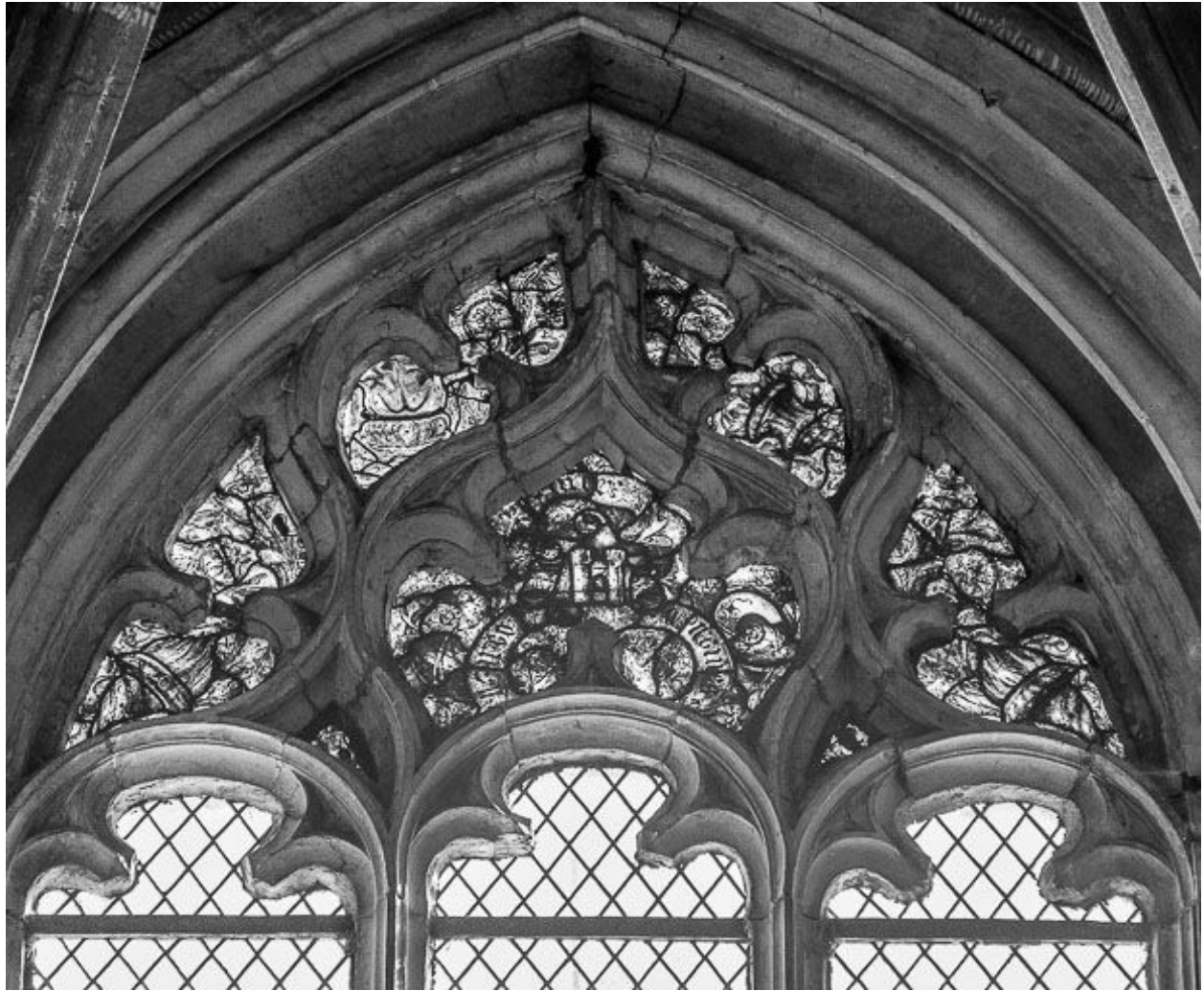
Tympan d'une des baies latérale.
