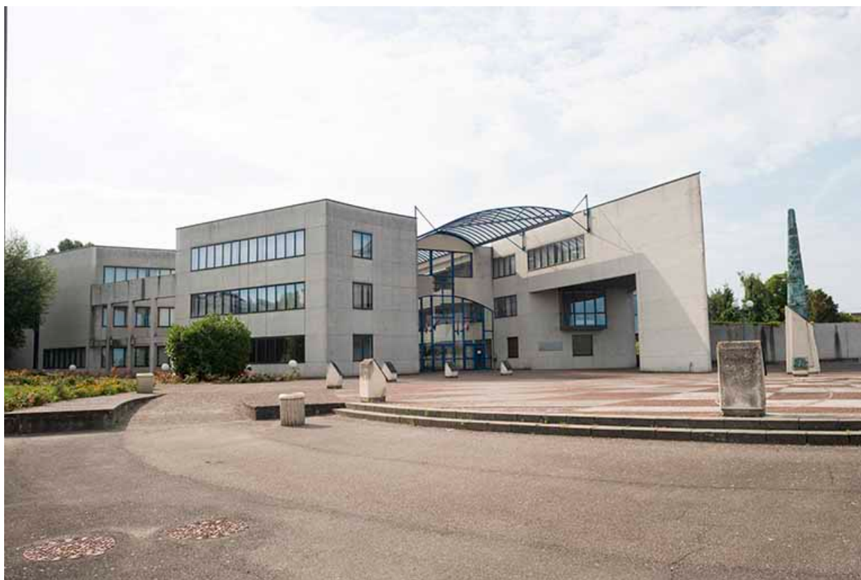
Parvis du lycée.
