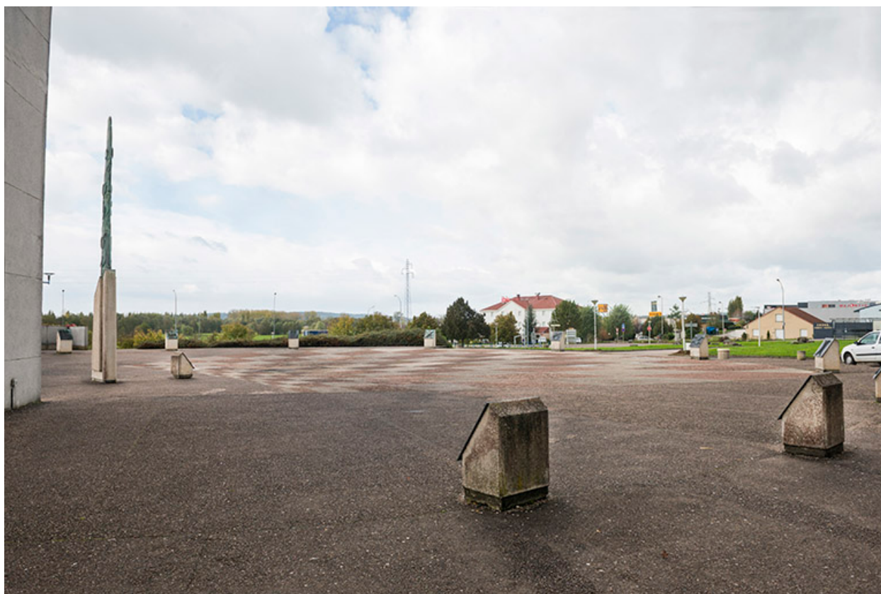
Parvis du lycée.
