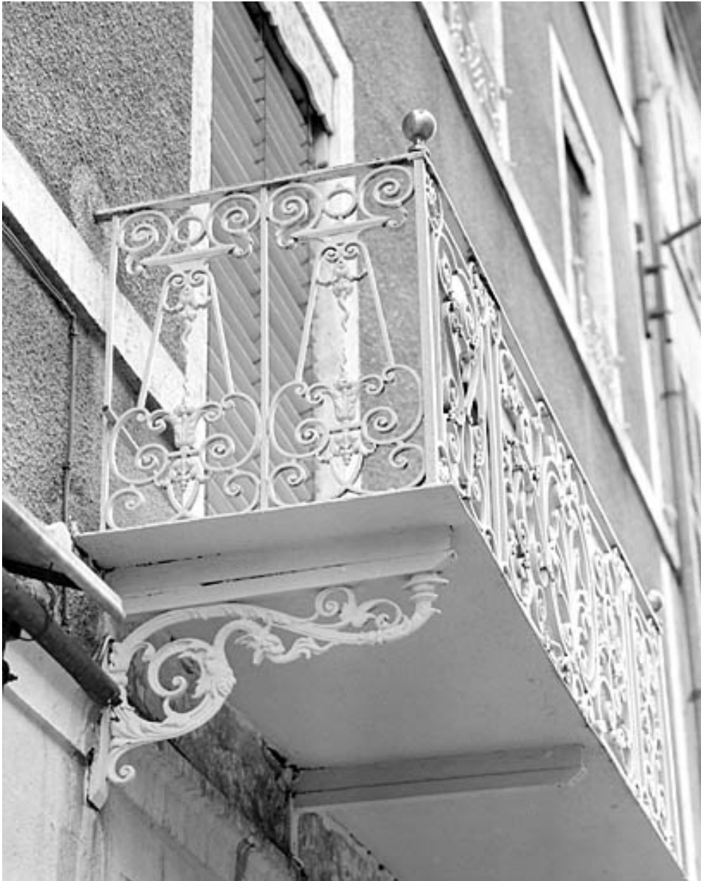
Balcon du premier étage : garde-corps et console.
