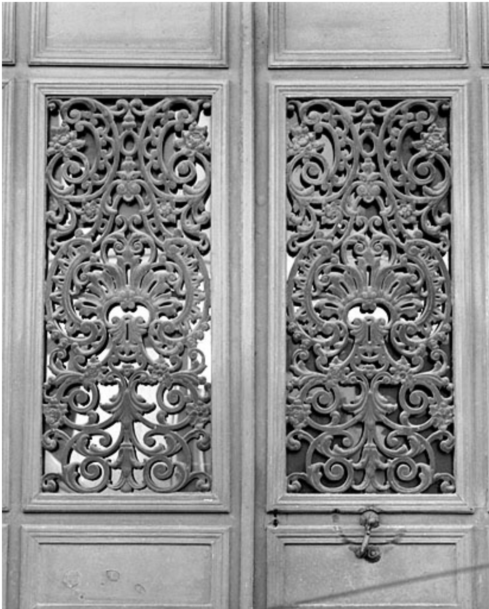
Entrée principale : grille des vantaux.
