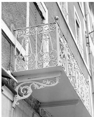
Balcon du premier étage : garde-corps et console. Phot. Yves Sancey IVR43_20033900477X
