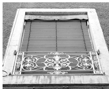
Fenêtre du premier étage et son garde-corps. Phot. Yves Sancey IVR43_20033900479X
