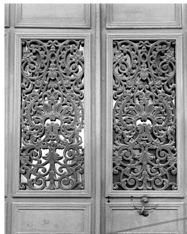
Entrée principale : grille des vantaux. Phot. Yves Sancey IVR43_20033900473X
