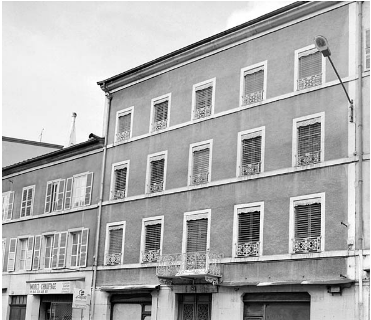
Elévation antérieure : les baies des étages.
