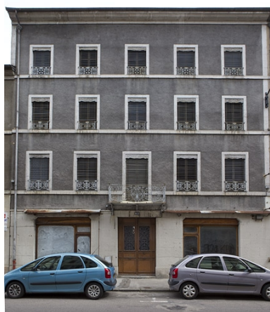
Elévation antérieure. Phot. Yves Sancey IVR43_20103900470NUC2A
