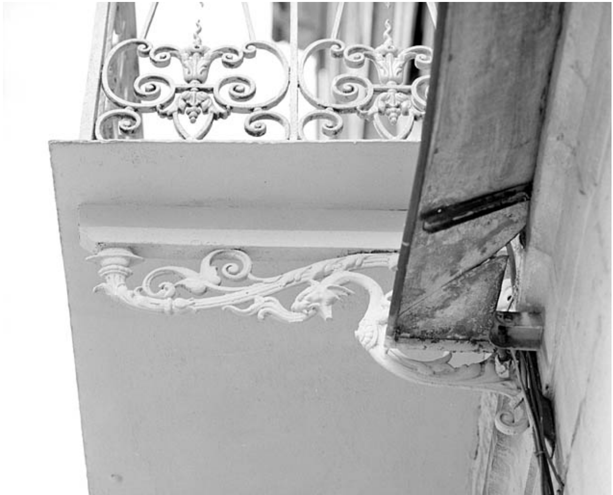
Balcon du premier étage : détail d'une console.
