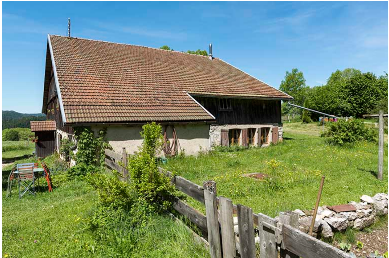
Façade latérale droite.
