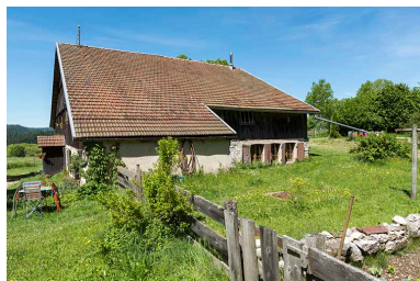
Façade latérale droite.
