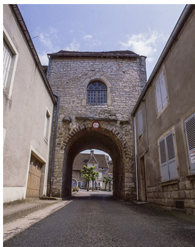
Porte Saint-Hilaire : façade extérieure. Phot. Yves Sancey IVR43_19857000095XA
