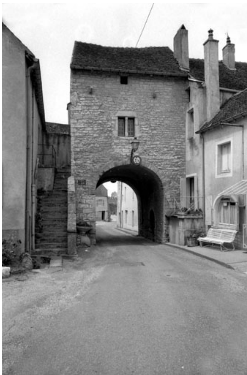
Porte Saint-Hilaire : façade intérieure.
