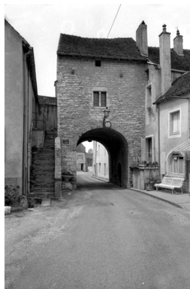
Porte Saint-Hilaire : façade intérieure. Phot. Bernard Lardière IVR43_19817000720Z
