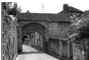
Porte Loigerot : façade intérieure. Phot. Bernard Lardière IVR43_19817000721Z
