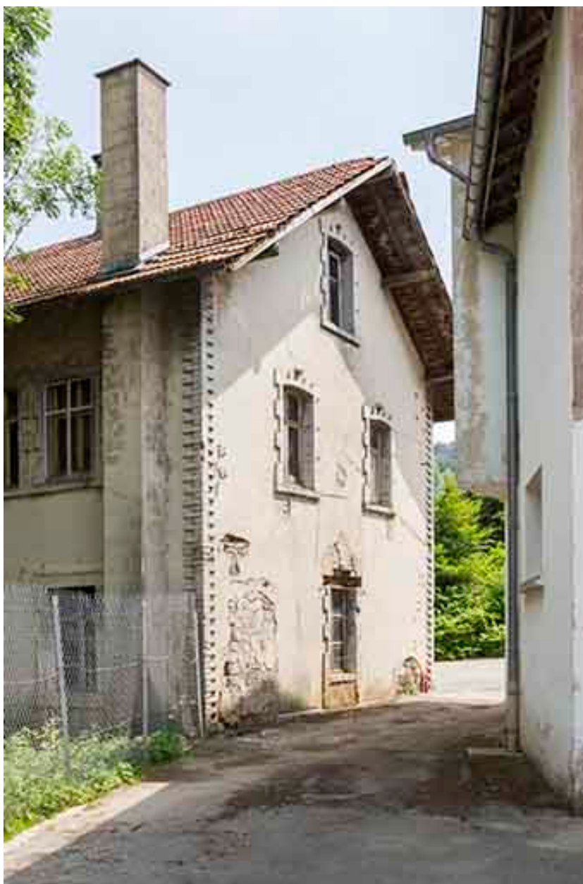
Atelier de fabrication occidental : mur pignon ouest.
