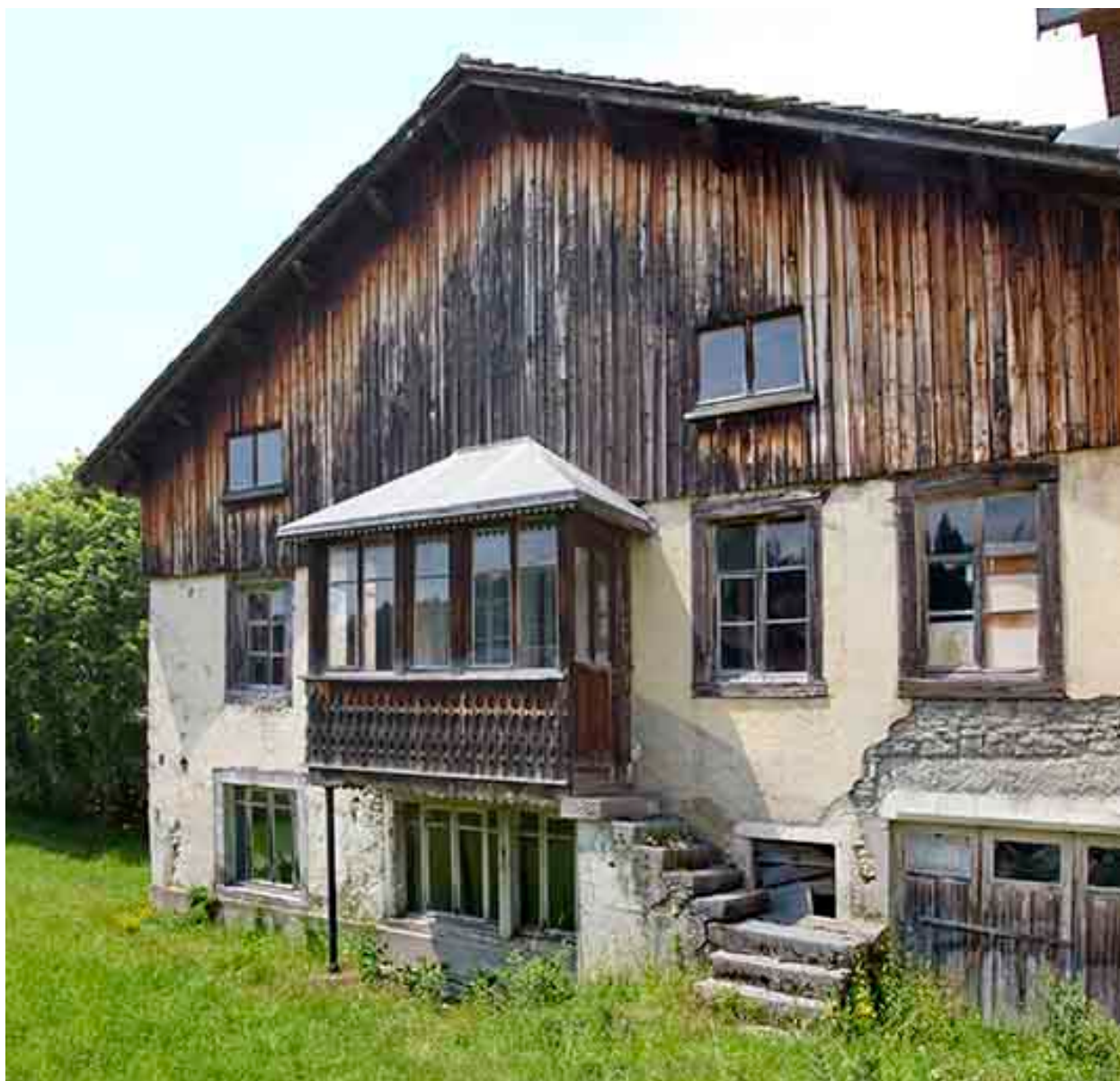
Logement d'ouvriers : façade antérieure.
