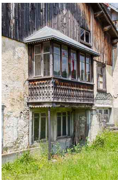
Logement d'ouvriers : porche. Phot. Yves Sancey IVR43_20132501087NUC2A
