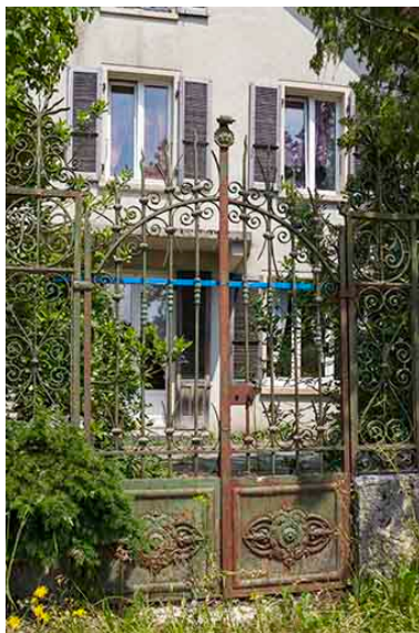
Logement patronal : grille de clôture. Phot. Yves Sancey IVR43_20132501094NUC2A
