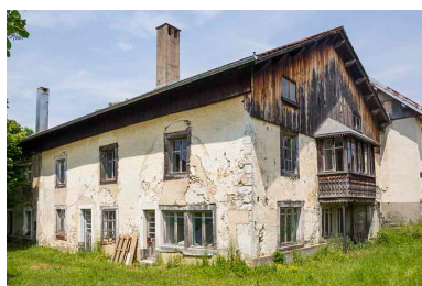
Logement d'ouvriers : façades antérieure et latérale gauche. Phot. Yves Sancey IVR43_20132501086NUC2A
