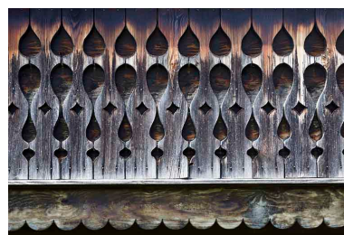
Logement d'ouvriers : lambrequin habillant le porche. Phot. Yves Sancey IVR43_20132501089NUC2A
