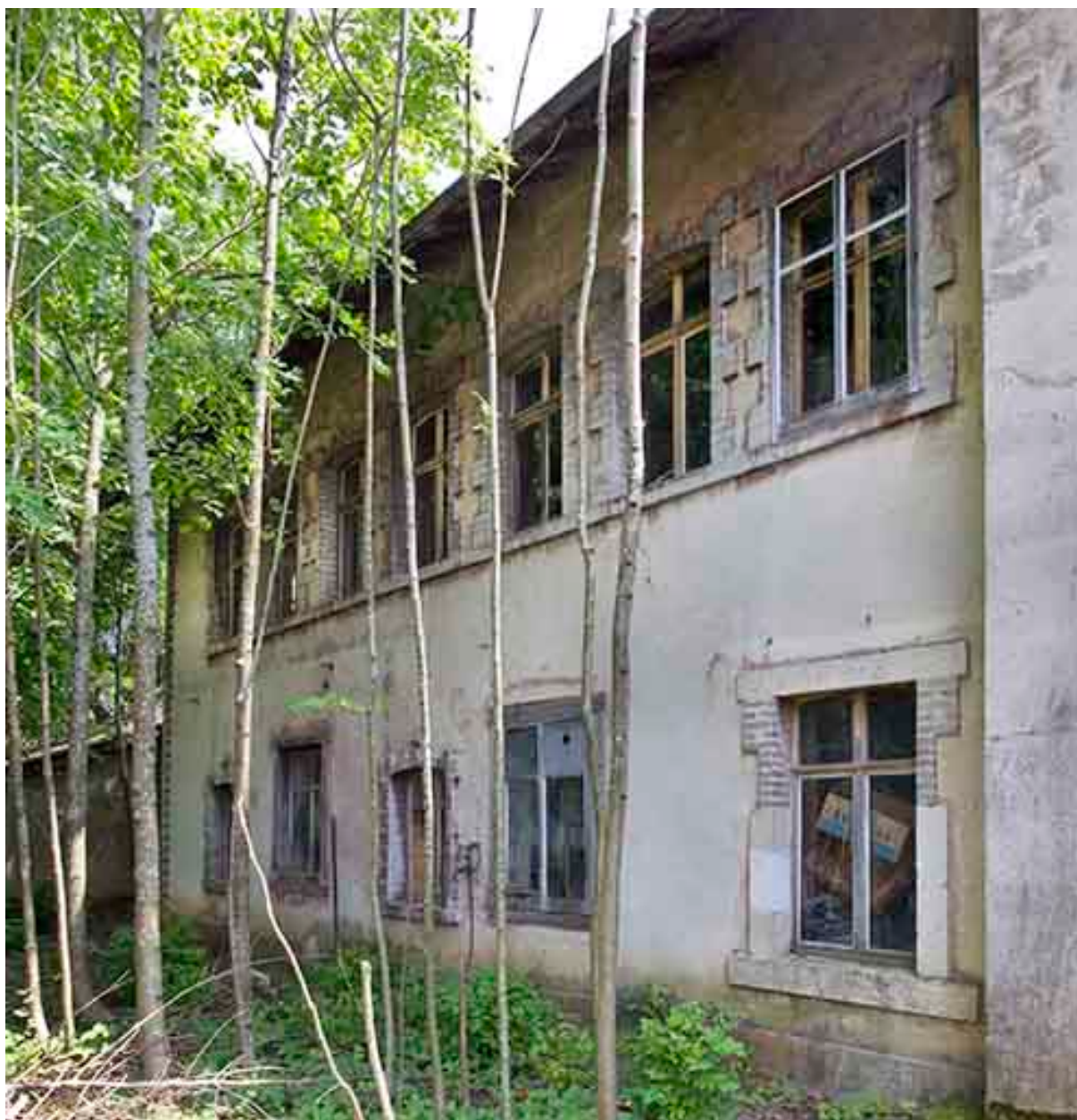
Atelier de fabrication occidental : façade postérieure.
