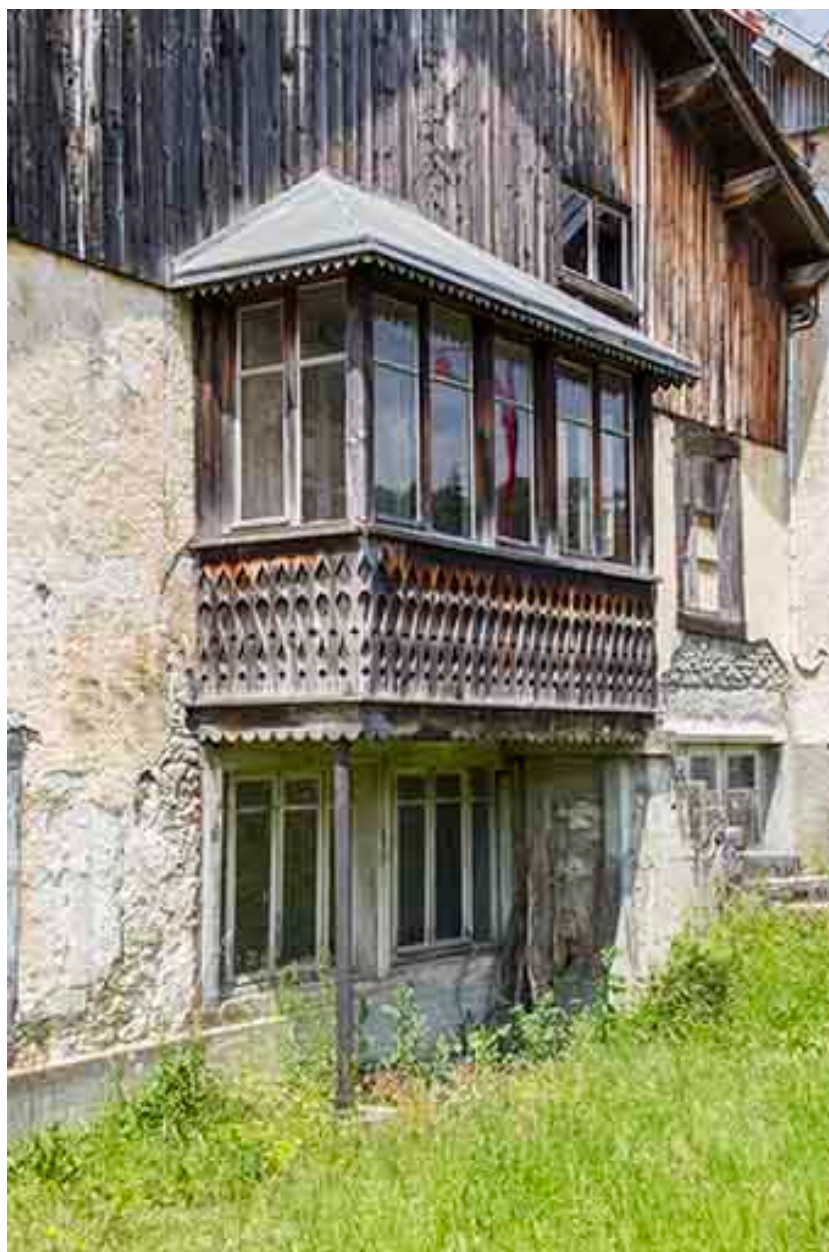
Logement d'ouvriers : porche.
