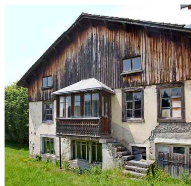
Logement d'ouvriers : façade antérieure. Phot. Yves Sancey IVR43_20132501090NUC2A
