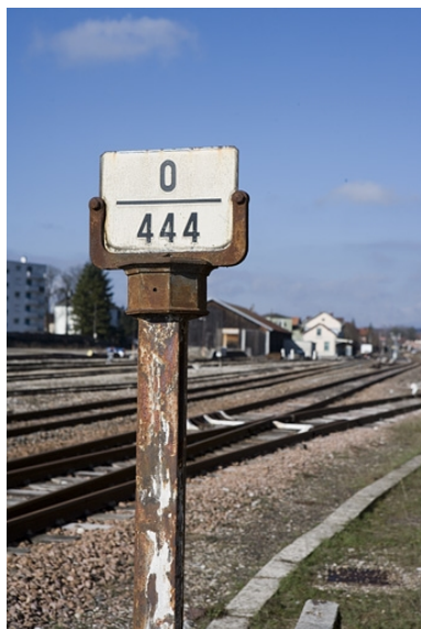
Face côté La Cluse. Le panneau signale que la voie est en palier sur 444 m.
