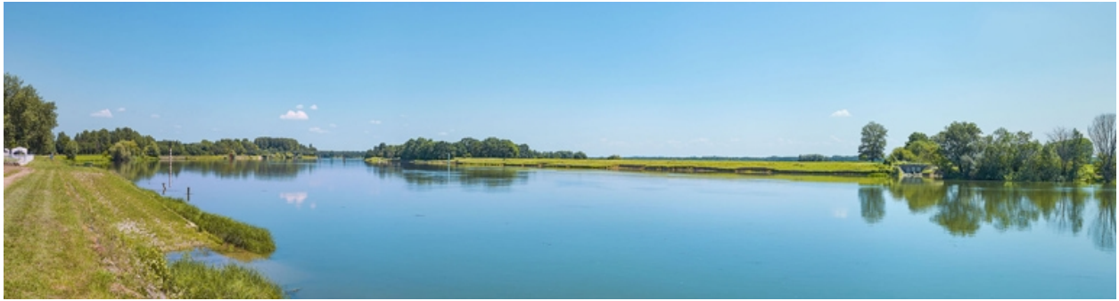
Rampe et perré du port d'Uchizy.
