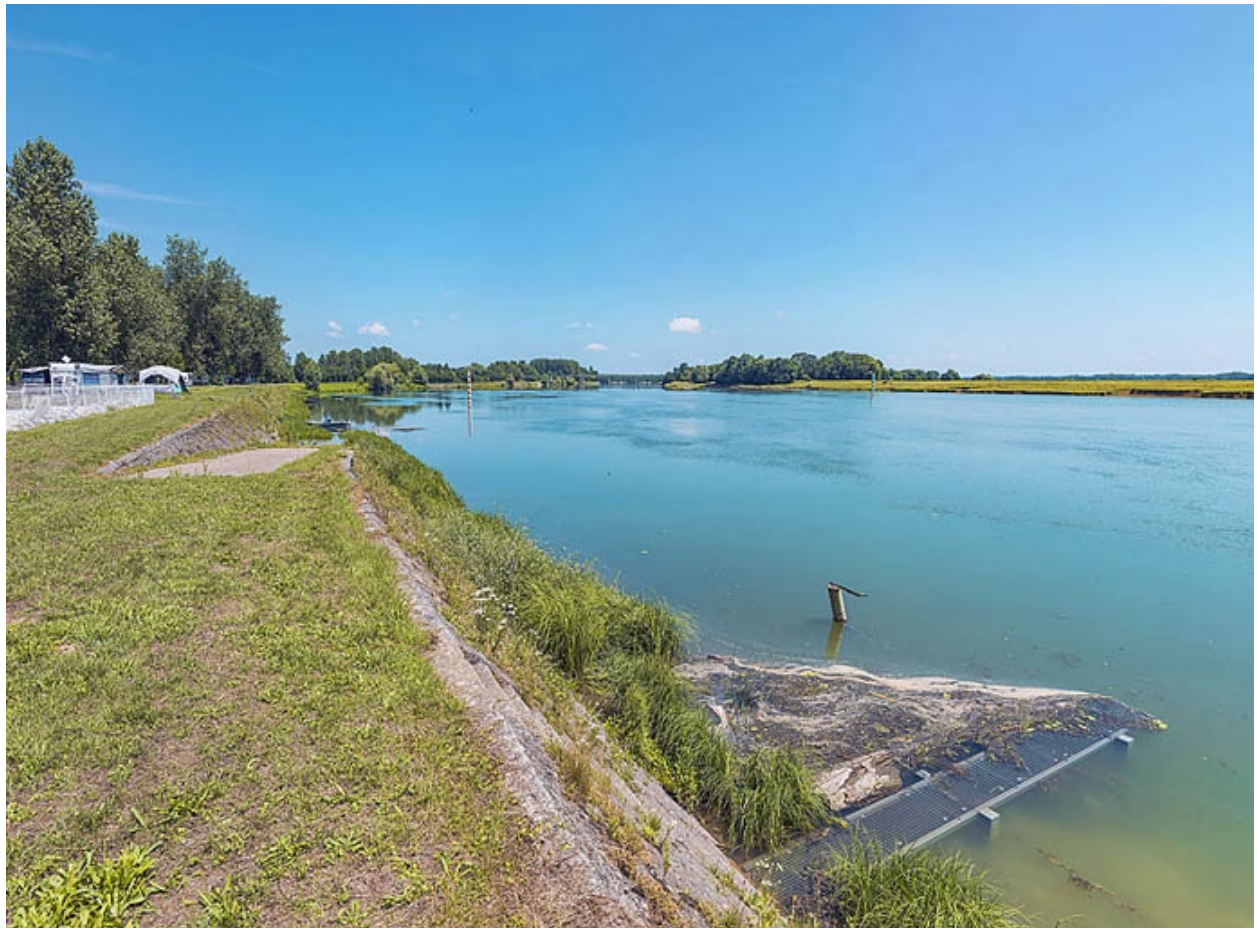
Rampe, perrés et escalier du port d'Uchizy.
