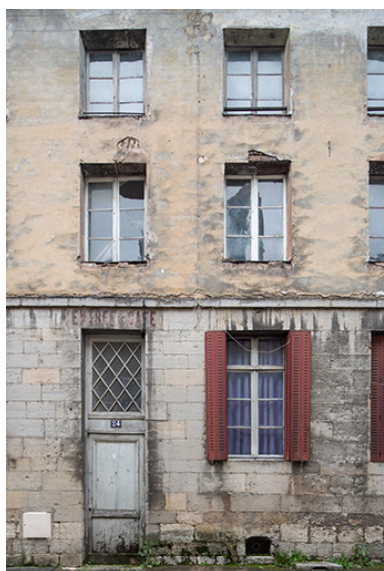
Travées centrales de la façade postérieure. Phot. Nicolas Waltefaugle IVR43_20253900294NUC4A
