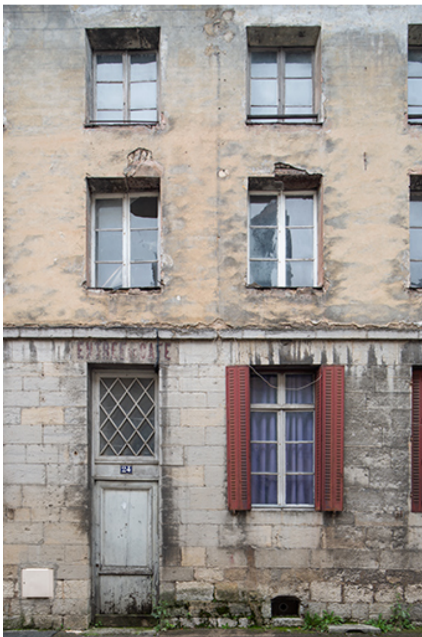
Travées centrales de la façade postérieure.
