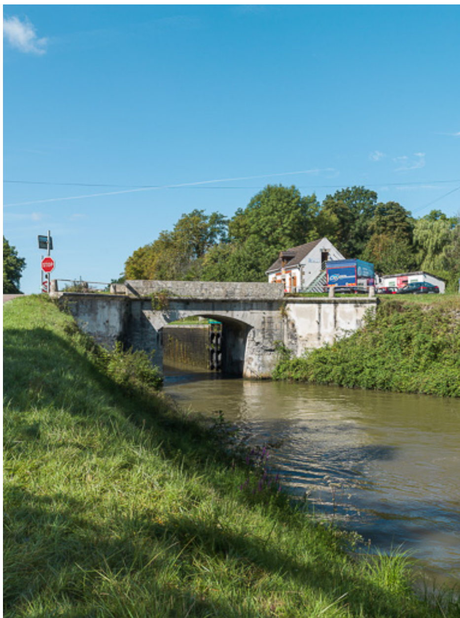
Vue d'ensemble du pont.
