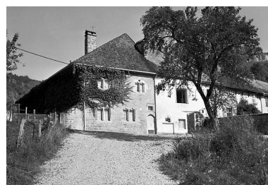
Maison située 8 route de Haute-pierre. Phot. Yves Sancey IVR43_19802501079X
