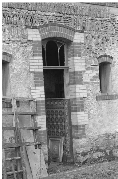
Entrée est de l'ancien pavillon nord. Phot. Frédéric Pillet IVR26_19997100817Z
