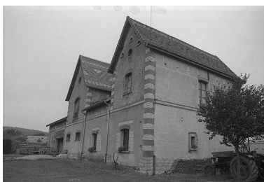
Façade ouest des écuries. Phot. Frédéric Pillet IVR26_19997100818Z
