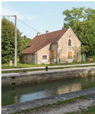
Vue de la maison éclusière. Phot. Pierre-Marie Barbe-Richaud IVR26_20178900146NUC2A
