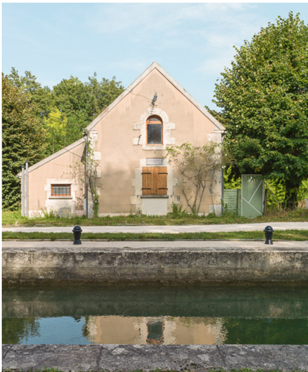
Vue de la maison éclusière.
