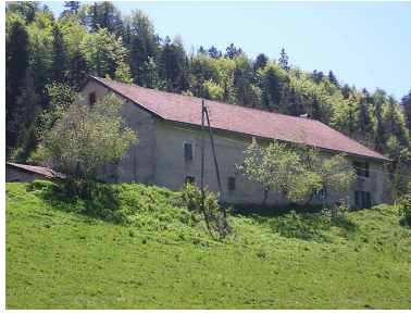
Façade postérieure. Phot. Marie-Pierre Reynet IVR43_20083900501NUC1A
